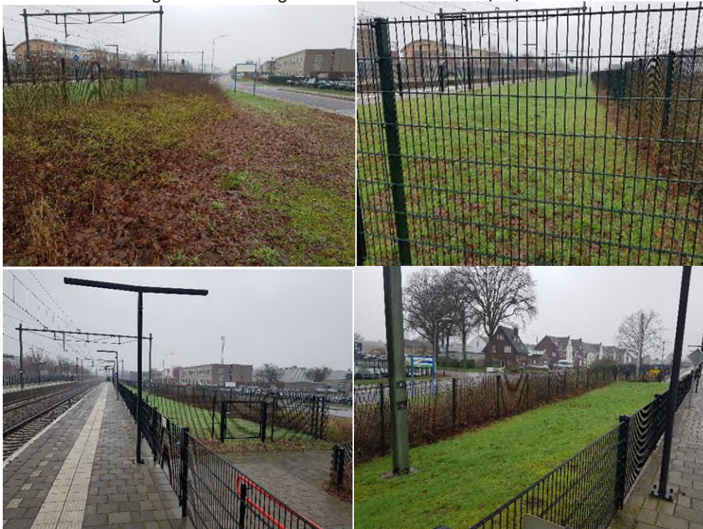
Figuur 2-4: Foto's van huidige situatie projectlocatie
