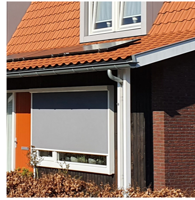
goten en hwa als gevelement
