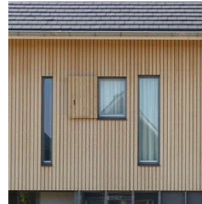
strakke detaillering van gevels
