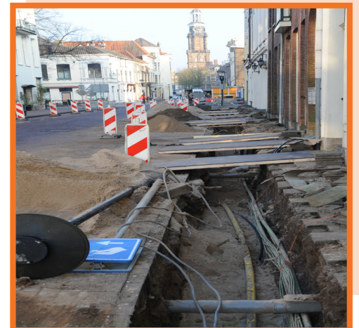
Kabels en leidingen in de grond (Bronvermelding: GAW | stichting RIONED)
