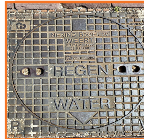
Putdeksel hemelwaterriool (Bronvermelding: RHDHV)
