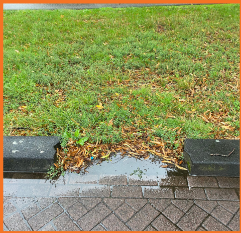
Infiltratiepunt (Bronvermelding: RHDHV)
