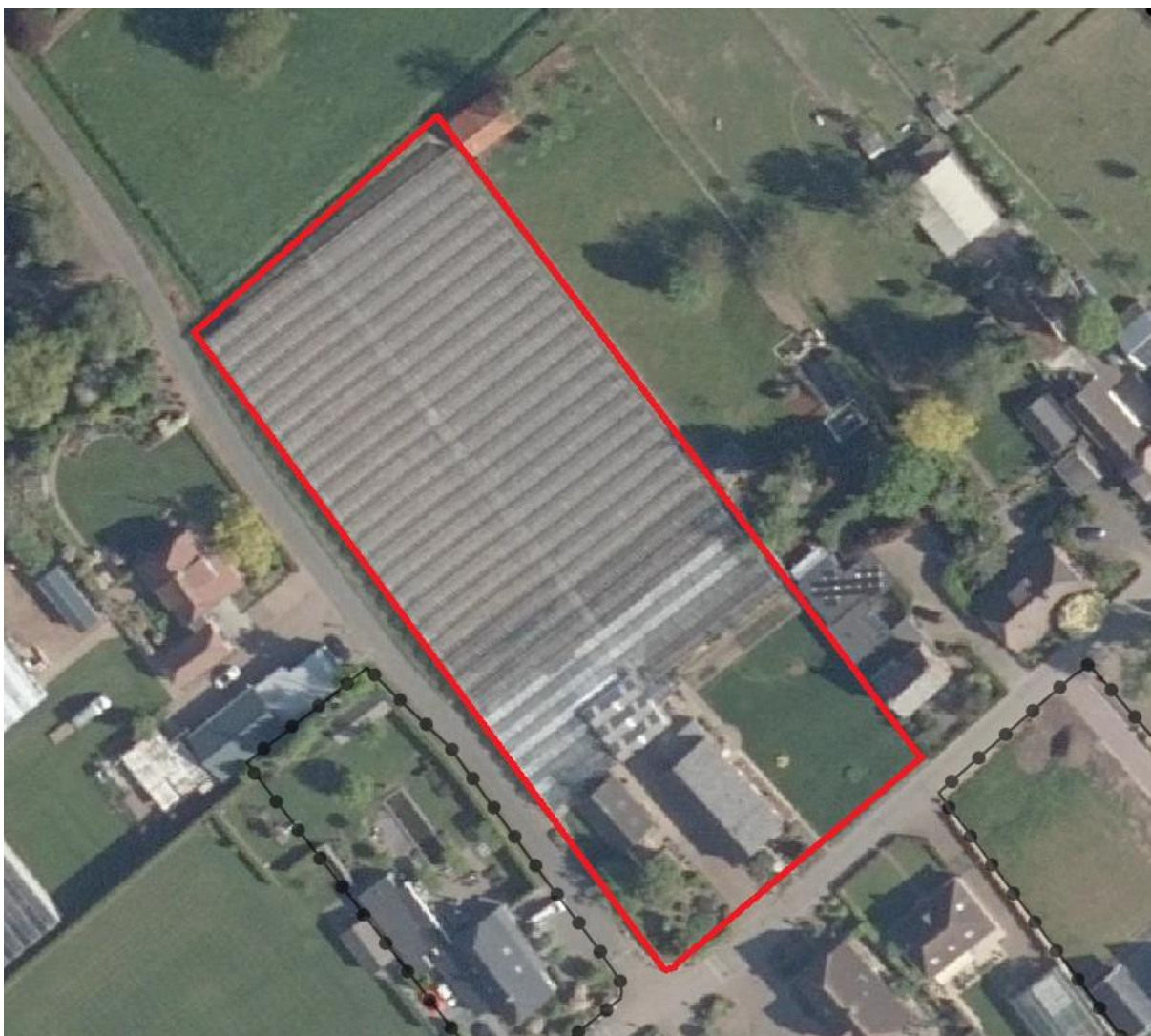
Afbeelding 2: Luchtfoto van het plangebied (bron: ruimtelijke plannen)
