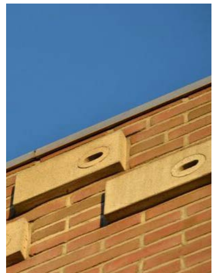
Nestkasten worden geïntegreerd in de gevel.
