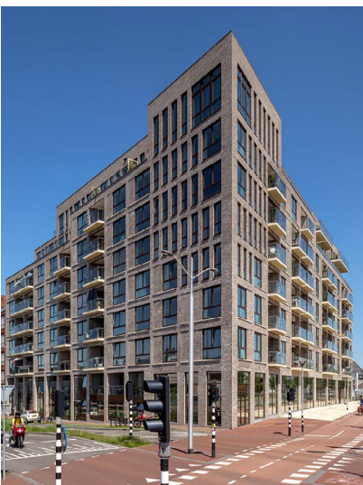
Hoogteaccenten vormen een opzichzelfstaand gebouwddeel.
