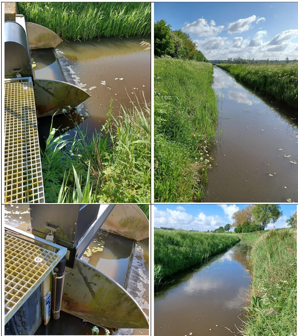
Foto's 5 t/m 8. Linksboven: overzicht stuw; rechtsboven: benedenstrooms; linksonder: detail stuw; rechtsonder: bovenstrooms.
