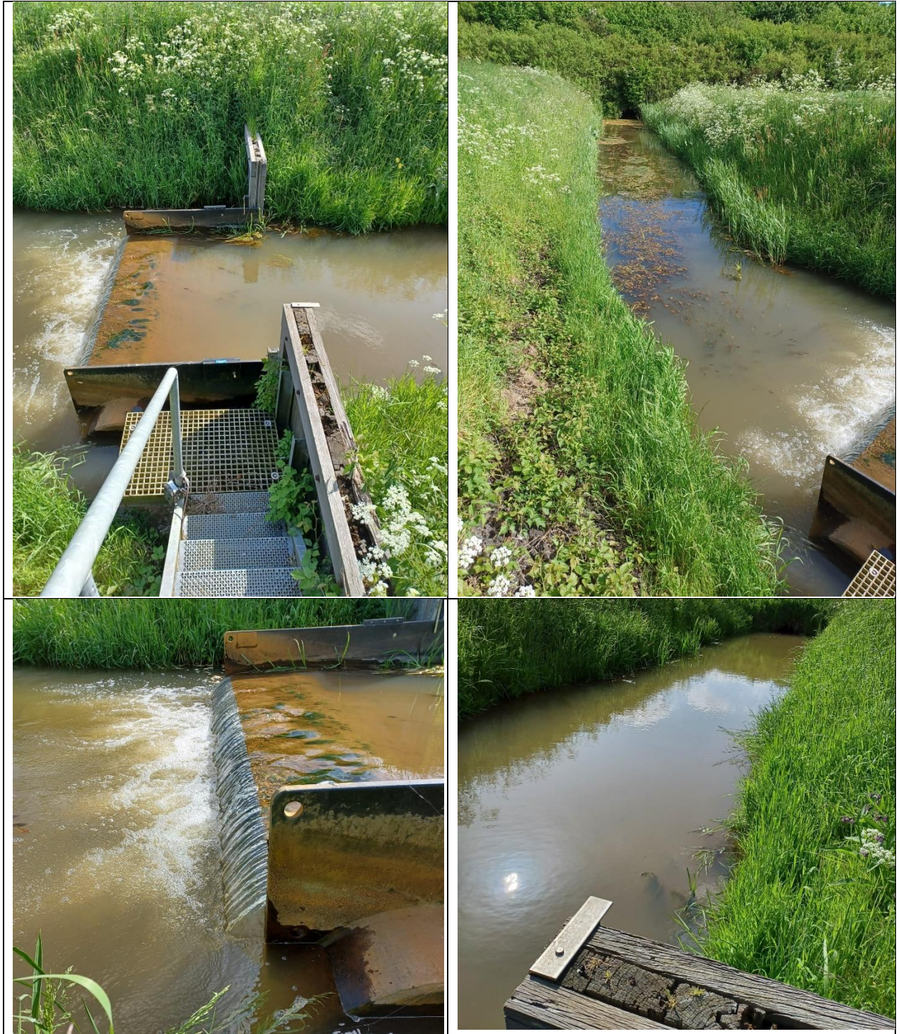
Foto's 1 t/m 4. Linksboven: overzicht stuw; rechtsboven: benedenstrooms; linksonder: detail stuw; rechtsonder: bovenstrooms.
