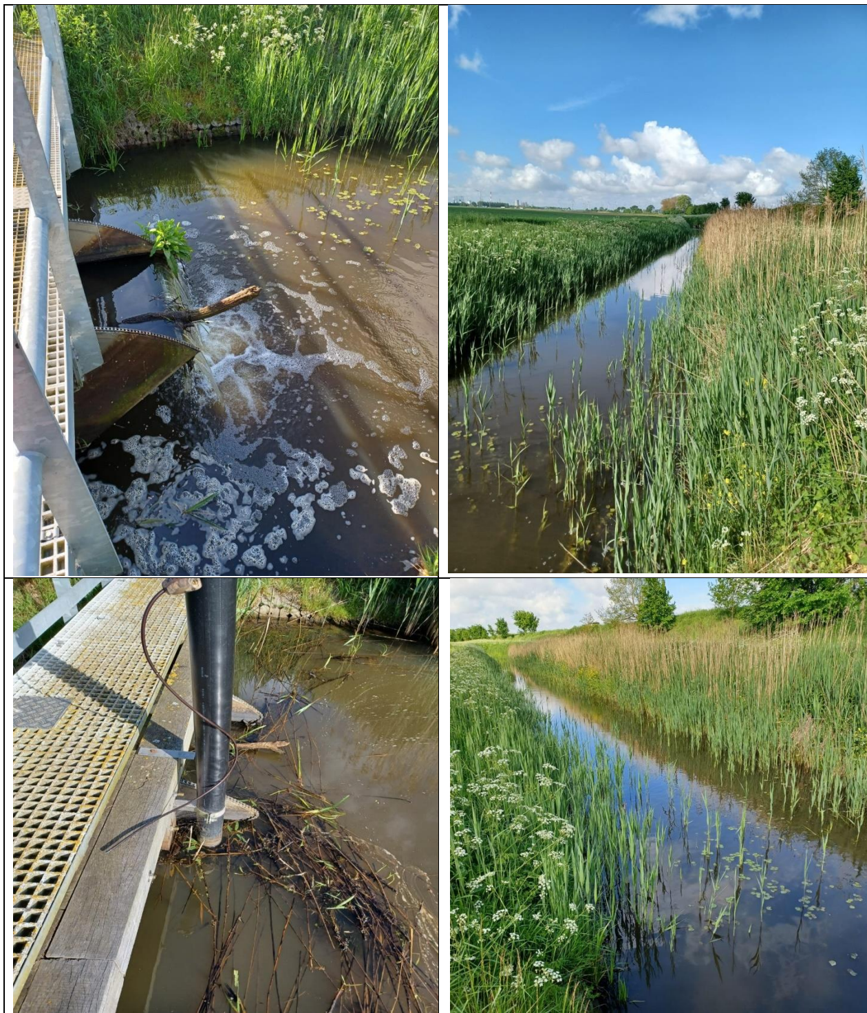
Foto's 9 t/m 12. Linksonder: detail stuw; rechtsboven: benedenstrooms; linksonder: detail stuw; rechtsonder: bovenstrooms
