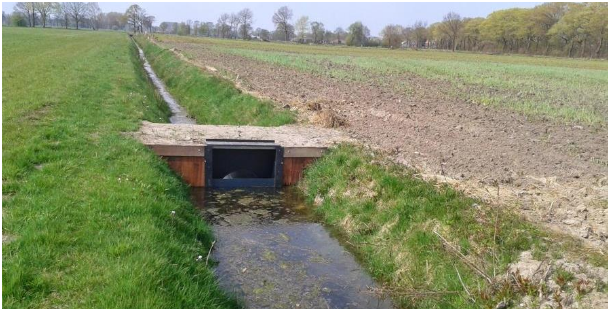
Figuur 16: Dam met overloopconstructie
