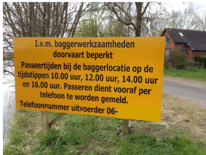
Stremming tijdens baggerwerkzaamheden (foto: Antea)
