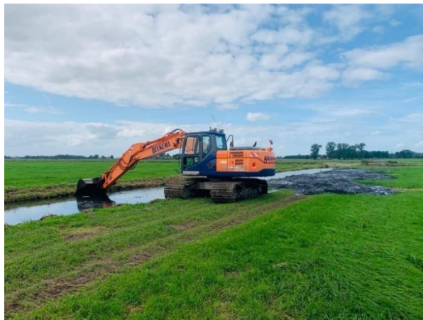
Onderhoudsbaggeren met een mobiele kraan (foto: waterschap Noorderzijlvest)
