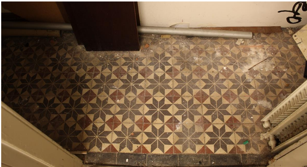
Figuur 36: Opname van de tegelvloer.
