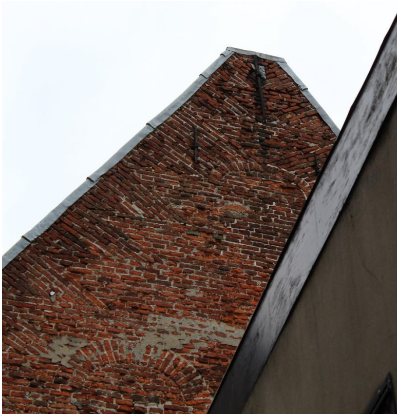
Figuur 32: Detailopname geveltop.
