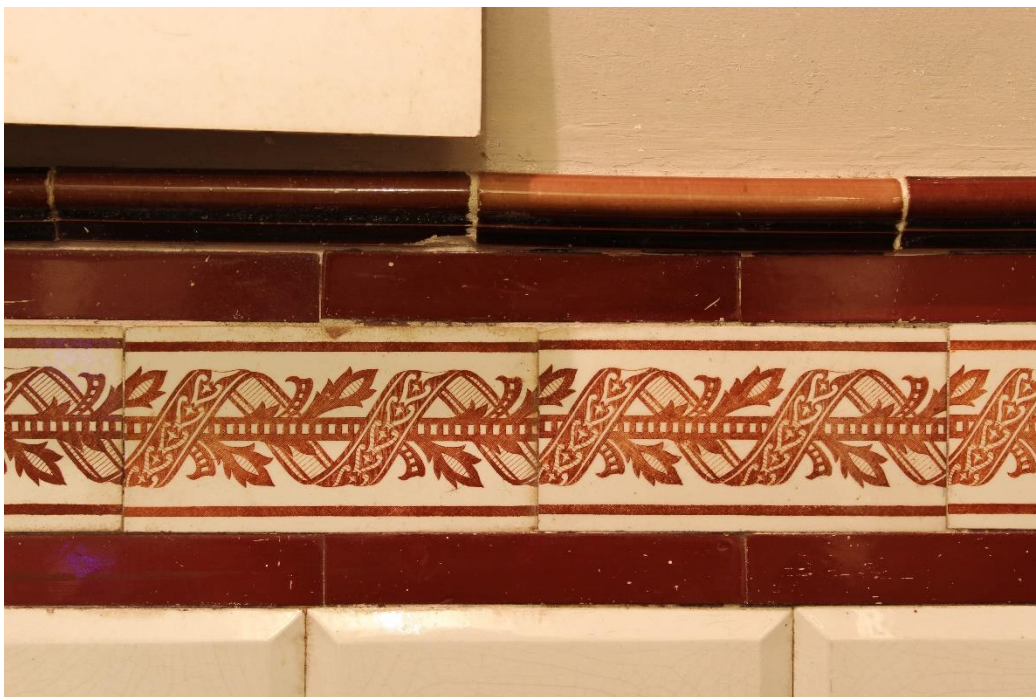
Figuur 37: Opname van de tegelafwerking.
