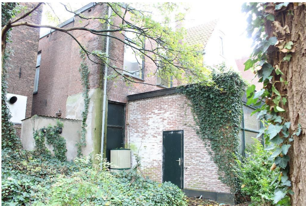
Figuur 28: Opname van de serre, achtergevel en steeg.
