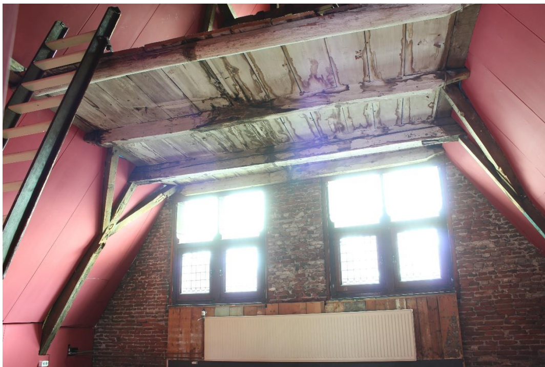
Figuur 50: Het onderste juk in de richting van de voorgevel.
