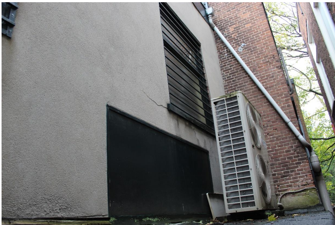
Figuur 27: Opname in de richting van het bouwdeel uit 1896.
