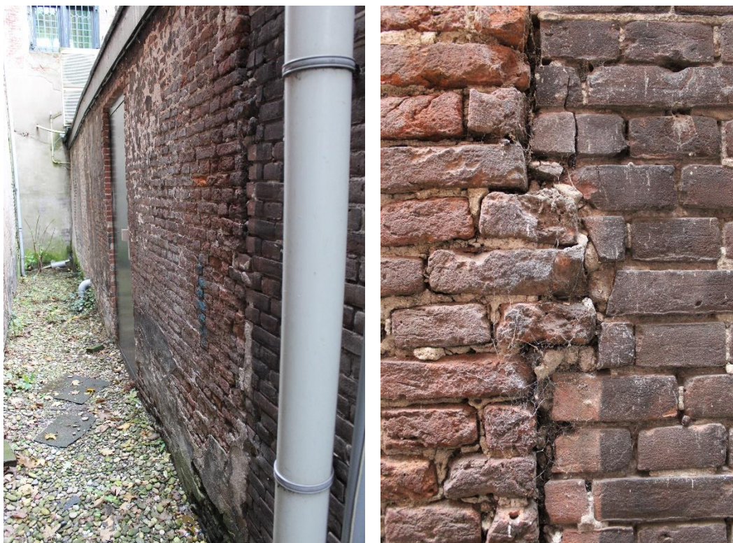
Figuur 23: Links: het oude geveldeel van de gang. Rechts de aansluiting van het muurwerk uit 1896 op het historische muurwerk.
