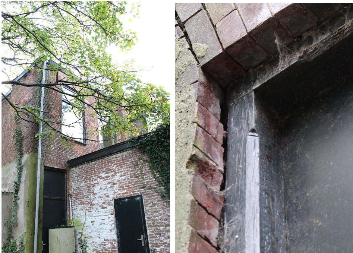
Figuur 29: Links de achtergevel, rechts een detailopname van het deurkozijn.
