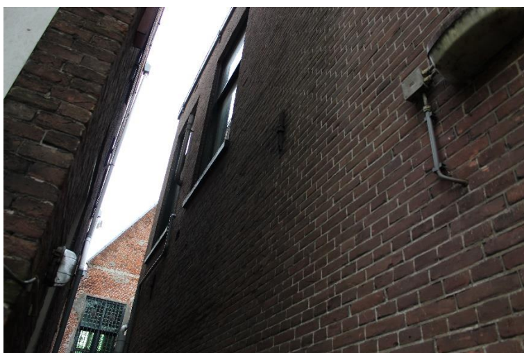
Figuur 30: De gevel uit 1896 ter hoogte van de verdieping.
