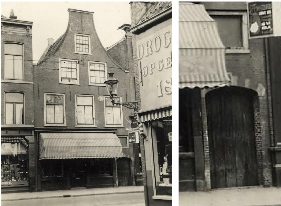
Figuur 8: De voorgevel van Kruisstraat 26 even voor 1932. Het voorkomen van de gevel doet sterk achttiende-eeuws aan. De uitsnede toont de entree van de steeg. Het venster boven de entree zorgde voor enig daglicht in de donkere gang.
