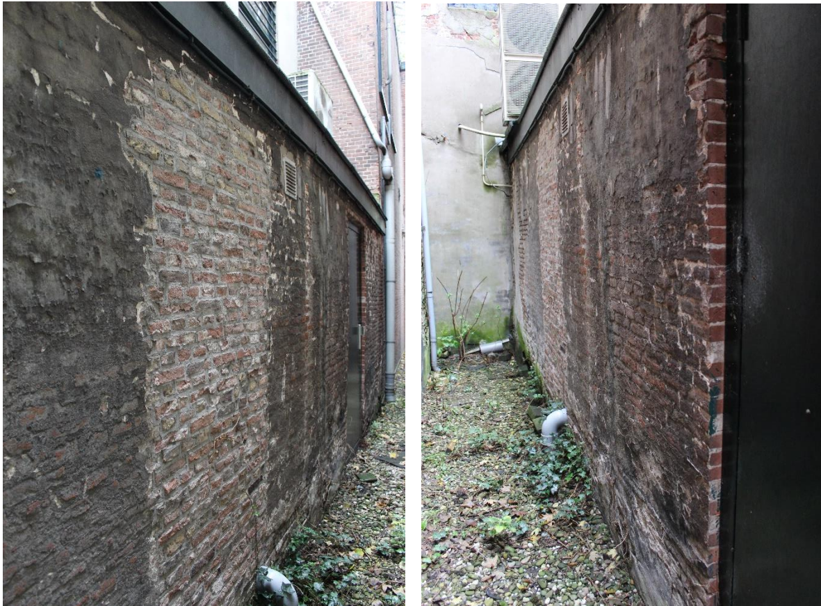
Figuur 24: Links het oude muurwerk waar de dichtgezette doorgang zich als bouwspoor aftekent. Op de foto rechts is te zien dat de huidige doorgang in het muurwerk werd gezaagd.
