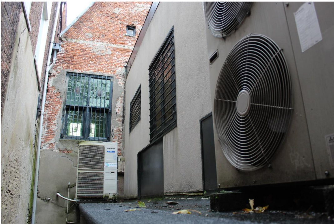
Figuur 25: Opname van het bepleisterde muurwerk ter hoogte van de verdieping.
