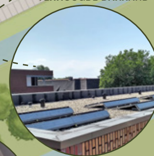
ZONNEPANELEN ACHTER VERHOOGDE DAKRAND
