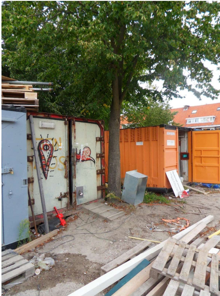
Afbeelding 4: Opslag van materiaal en materieel binnen de beschermde boomzone (kroonprojectie + 1,5 meter) dient ten alle tijden voorkomen te worden
