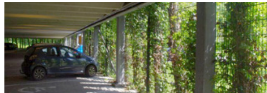
parkeergarage met begroeide gevel
