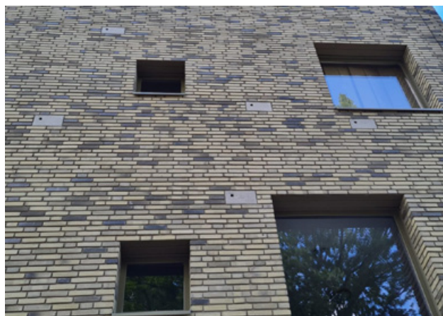
afgestemd op ritmiek gevel
