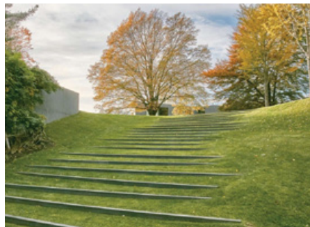
Voorbeeld overgang met een opsluitband in de vorm van een landschappelijke trap
