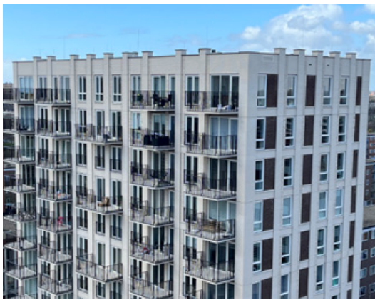
hoge dakrand. verbijzondering dakbeëindiging
