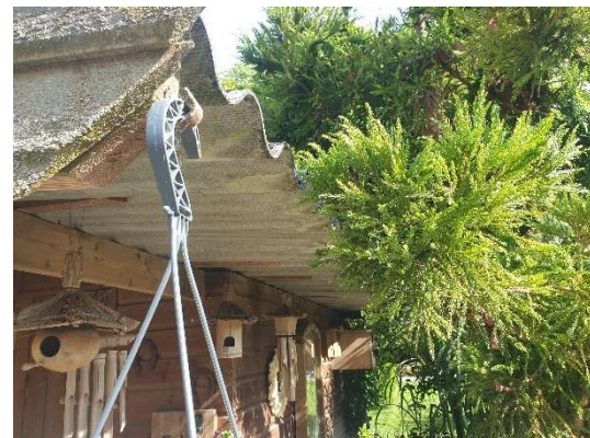
Foto 8: Detailfoto dakbedekking afdakje
