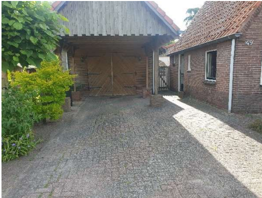
Foto 3: Oprit en carport (linkerzijde)
