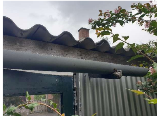
Foto 8: Schuur en achtertuin rechts achter woning
