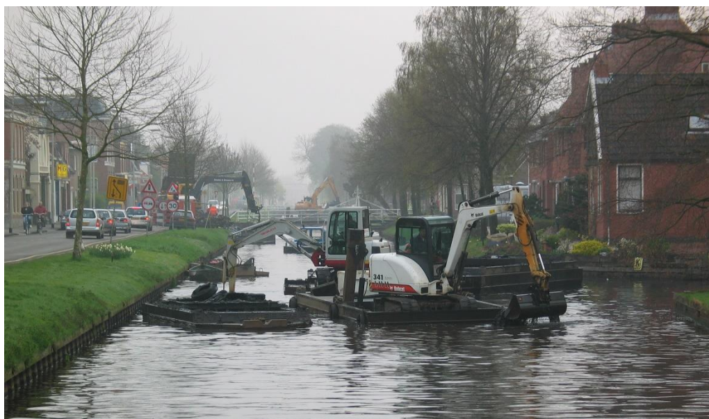
Baggeren Oosterdiep Veendam (foto: Waterschap Hunze en Aa's)
