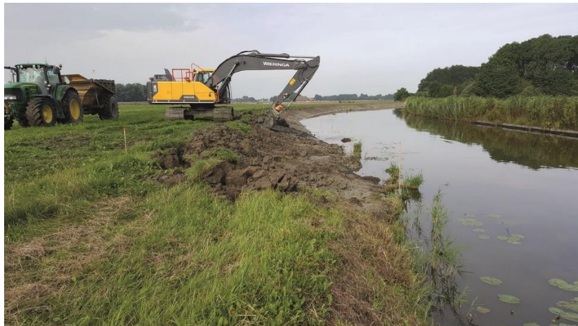
Aanleg natuurvriendelijke oever (foto: Noorderzijlvest)
