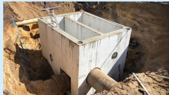
Foto: Aanleg riolering en putten (Marialaan – Reusel)
