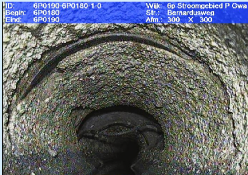
Foto: Inspectiebeelden rioolinspectie (Bernardusweg – Lage Mierde)
