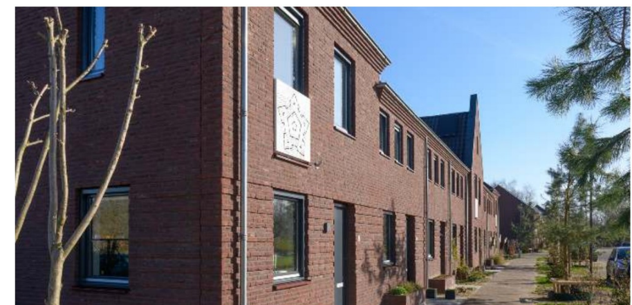
verspringing in de gevel
