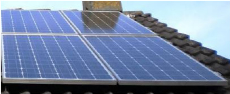
zonnepanelen in rechthoekig vlak leggen
