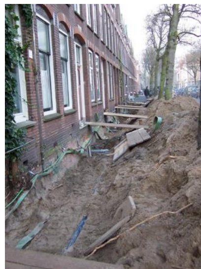
Figuur 6: Werk aan kabels en leidingen.
