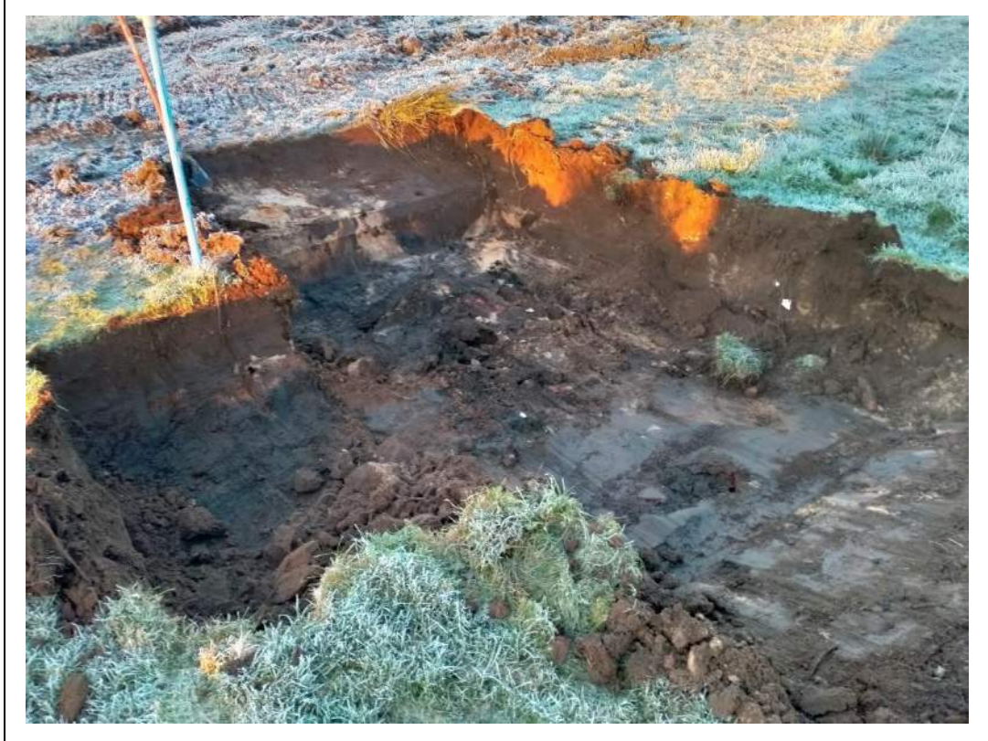
Foto 1. Ontgraving PAK-spot
