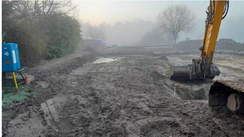
Foto's van te ontgraven ondergrond uit Bouwput Binkhorsterkerkpad 14 in De Lutte d.d. 14 februari 2023 Projectcode 23012471
