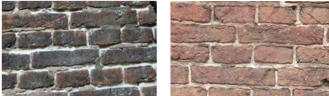
Figuur 4: Zeer ondiepe voegen. Links: muurdetail op zuidzijde en Rechts: muur op straatzijde.
