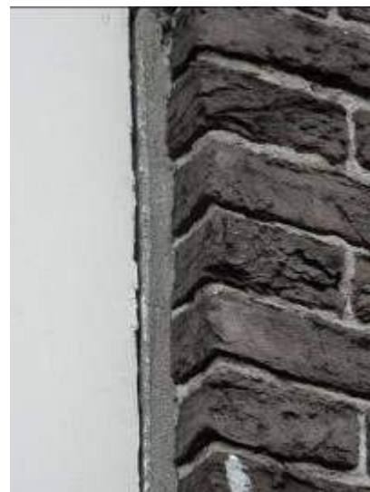
Figuur 10: Links, uitgevallen mortel aansluiting kozijn-metselwerk; rechts, spleet tussen kozijn en mortel
