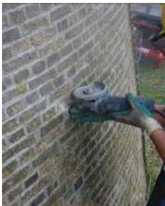
Aanbrengen ontspanningsleuf midden in voeg
