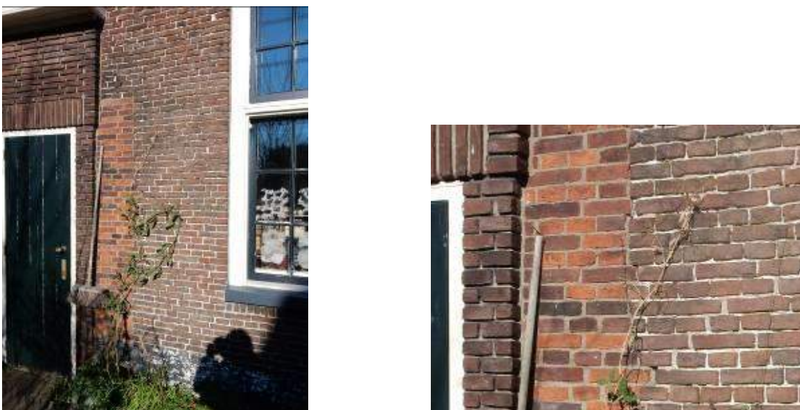
Figuur 7: Reparatie bij woning 1
