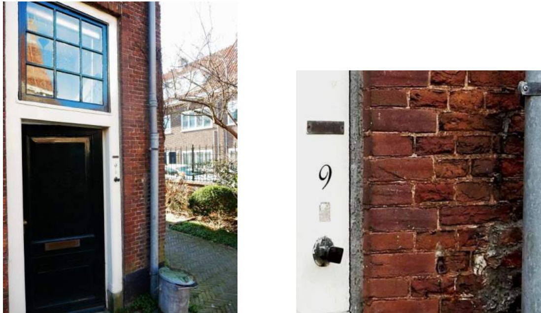
Figuur 8: Reparatie bij woning 9
