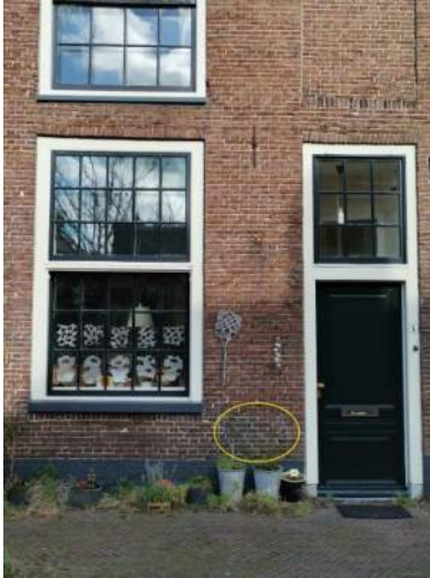
Figuur 9.2: Plaatselijk ondeskundig voegherstel (op diverse plekken aangetroffen)
