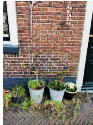
Figuur 9.2: Plaatselijk ondeskundig voegherstel (op diverse plekken aangetroffen)
