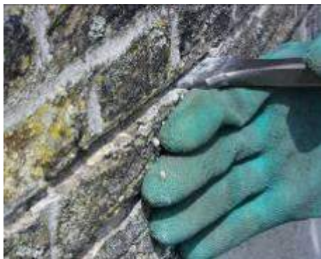
Verwijderen voeg met pneumatische hamer en bijv Spytze Wedia bijtels
