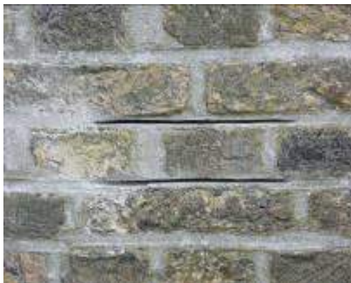
Aanbrengen ontspanningsleuf midden in voeg
