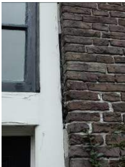
Figuur 10: Links, uitgevallen mortel aansluiting kozijn-metselwerk; rechts, spleet tussen kozijn en mortel
