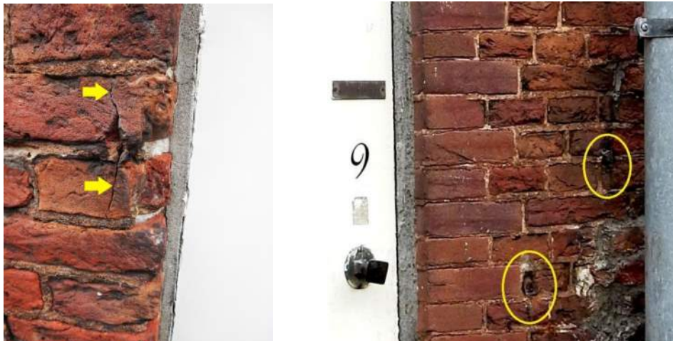
Figuur 11: Plaatselijke scheurtjes (links) als gevolg van roestend staal en het voorkomen van roestend (rechts).
