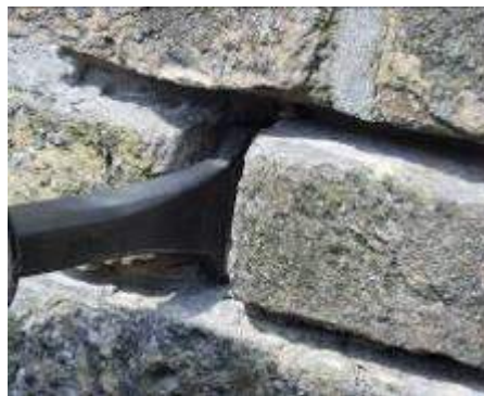
Verwijderen voeg met pneumatische hamer en bijv Spytze Wedia bijtels
