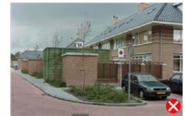
sterk afwijkend materiaalgebruik
