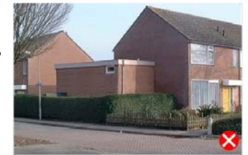
zijaanbouw te hoog
