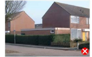
zijaanbouw te dicht bij voorgevelrooilijn
