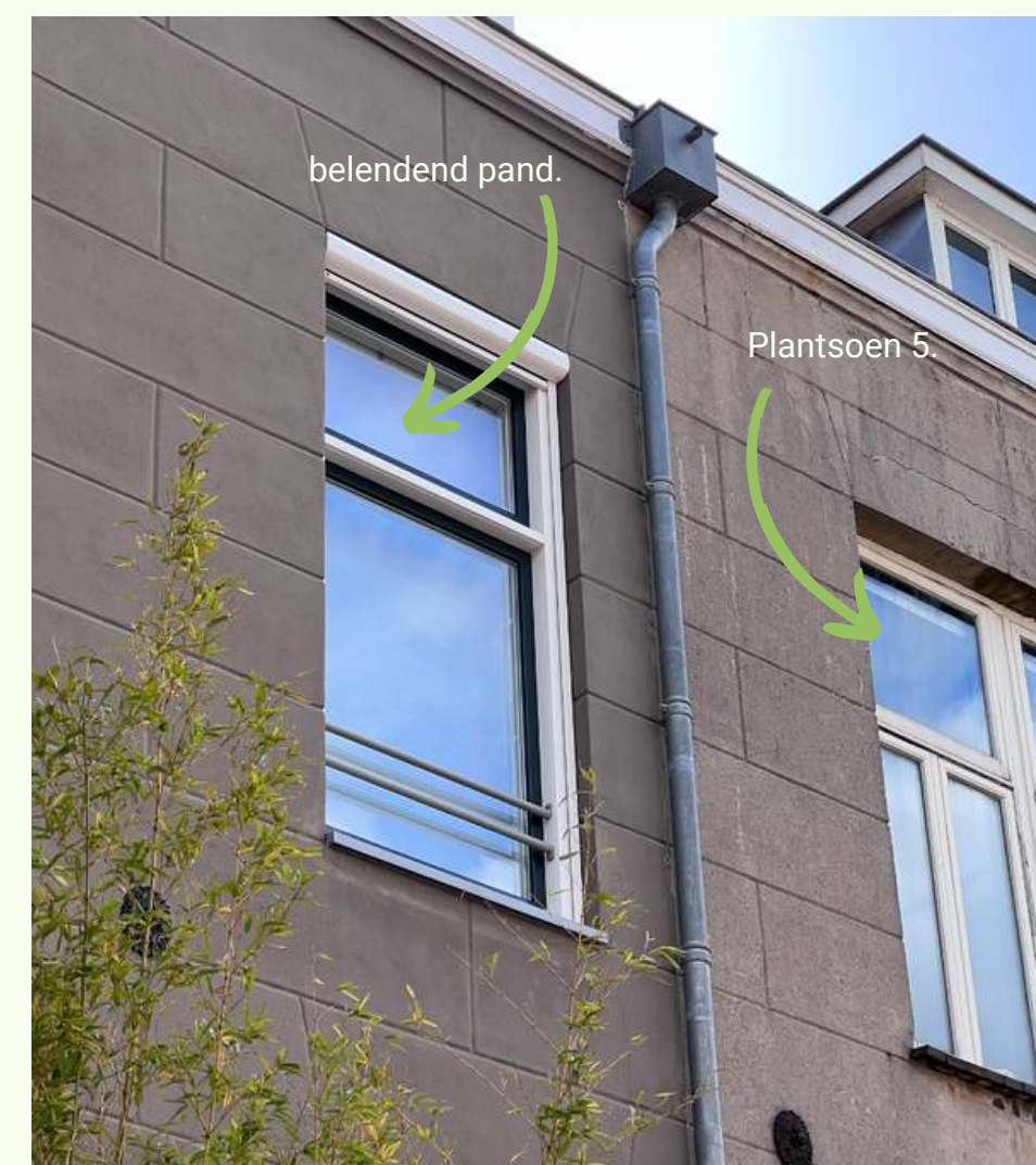
achtergevel - gevelkozijnen tweede verdieping.
