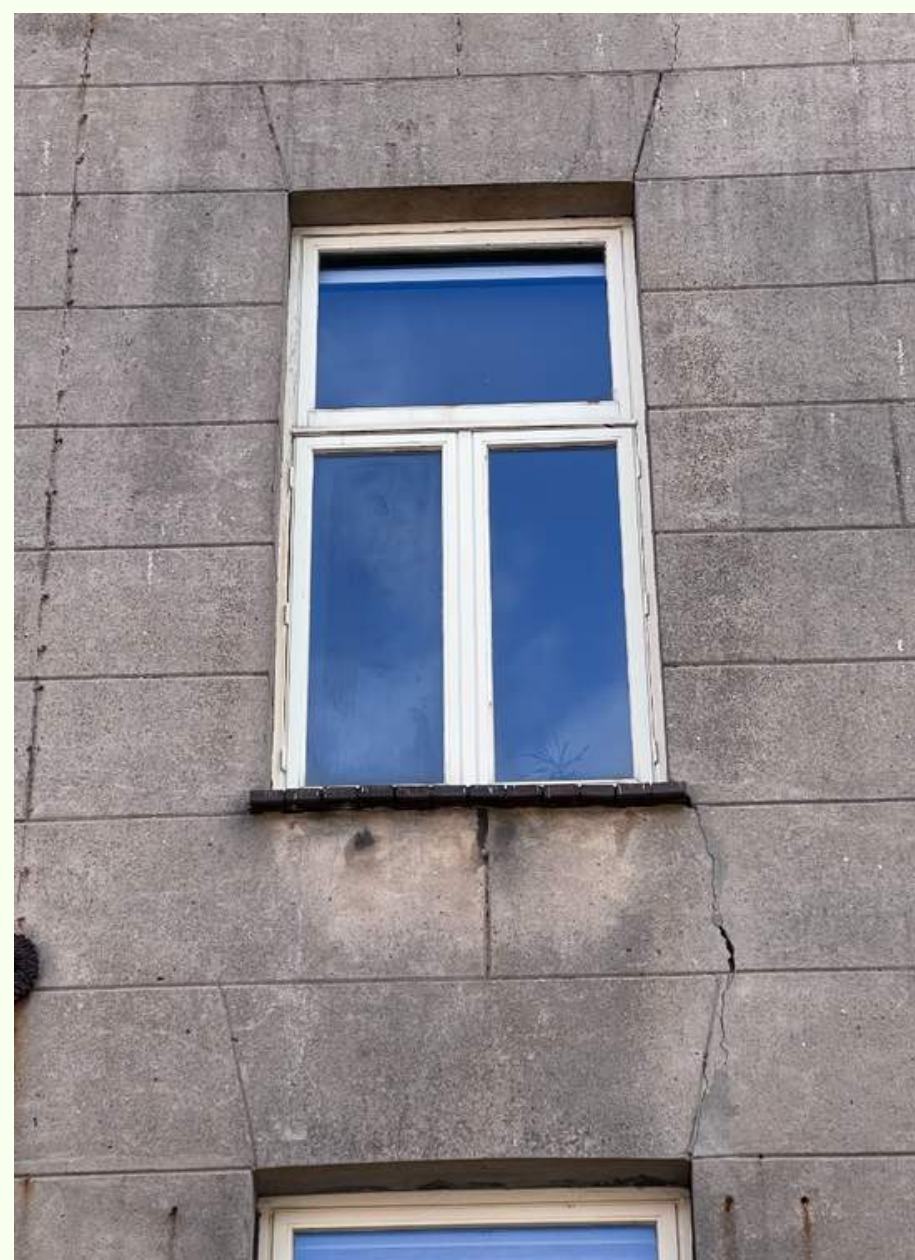
achtergevel - gevelkozijn tweede verdieping.
