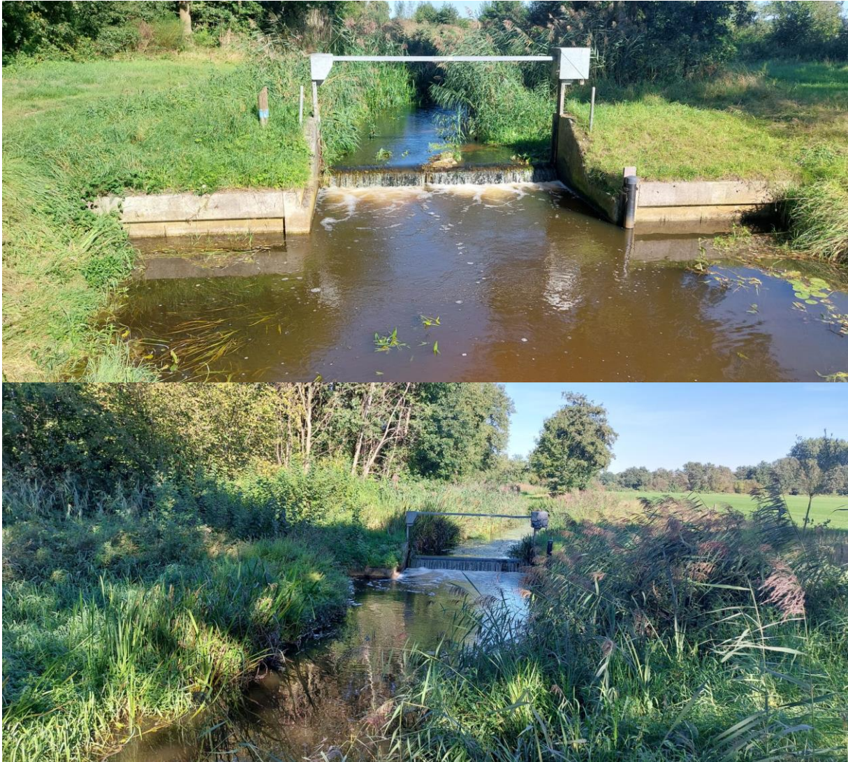
Figuur 2. Impressie van de ingreeplocatie. Boven stuw 251D, welke wordt vervangen door cascades. Onder stuw 251C, deze wordt geautomatiseerd en voorzien van een Smart Vislift.
