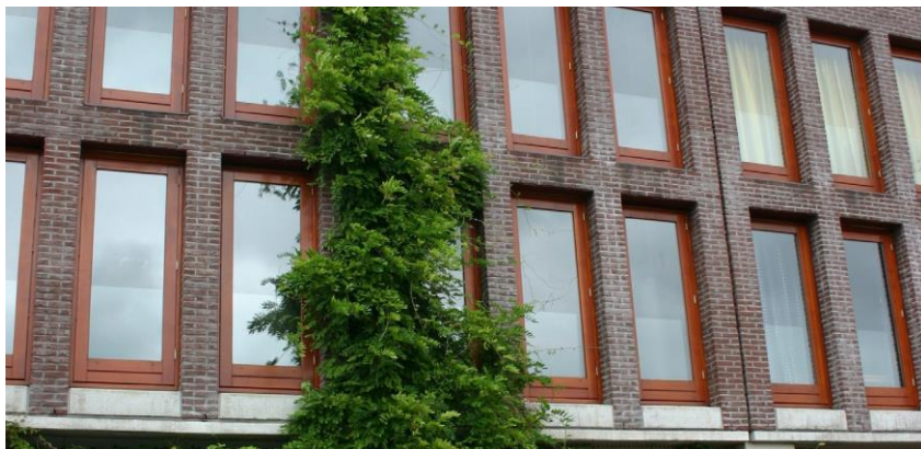
klimplant aan gebouw
