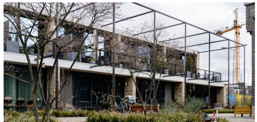
constructies voor groen aan gevels
