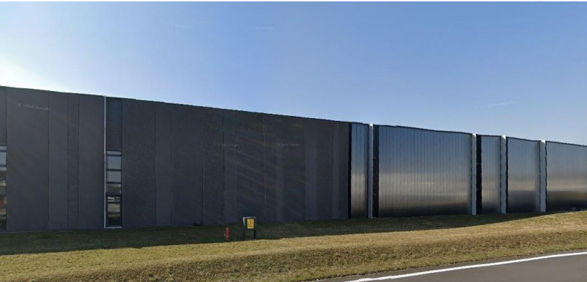
verticale geleding groter bouwwerk (bron: google maps)
