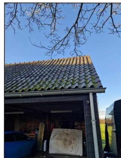
Fig. 2.9 Detailopname schuur (bron: FF Solutions)
