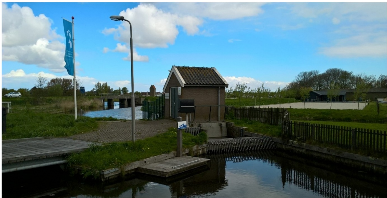
Figuur 1: Gemaal Groot-Limmerpolder Zuid
