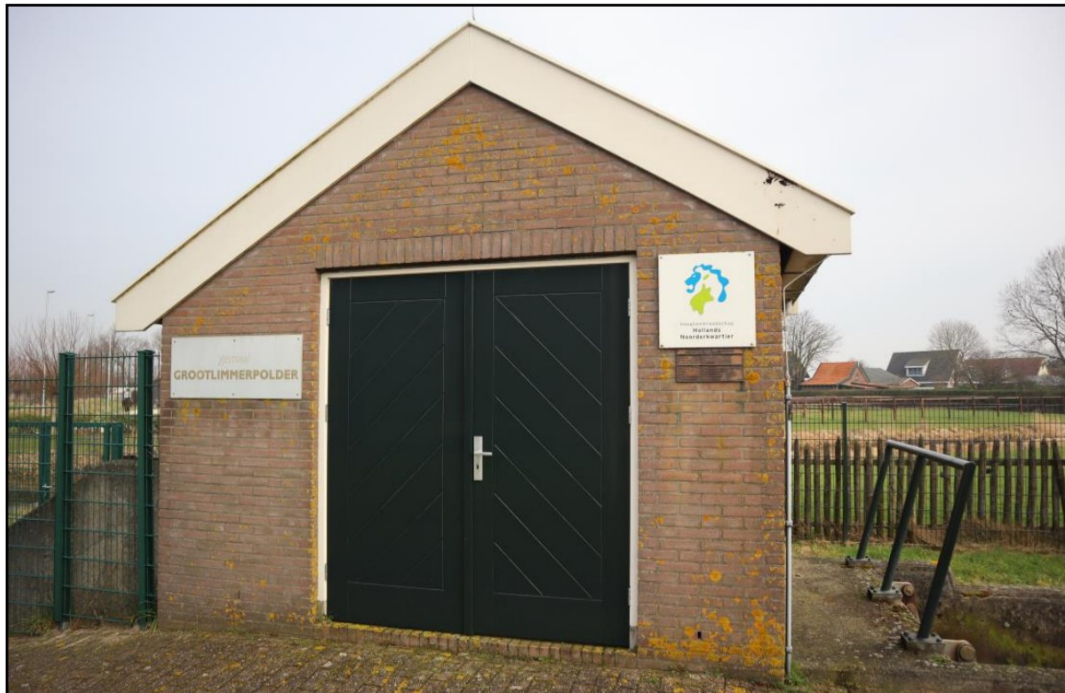
Afbeelding 4 Impressie omgeving plangebied. Nieuwe gemaalgebouw. Aan dit gebouw vinden geen werkzaamheden plaats.
