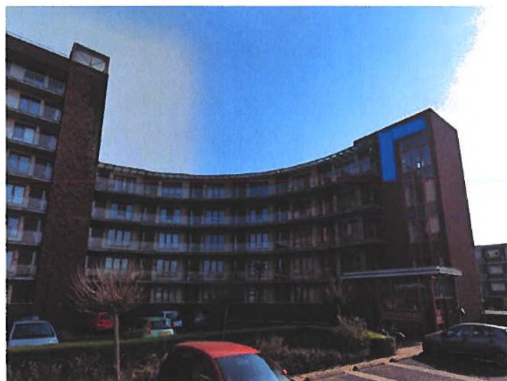
Figuur 5: Locatie 20 aanvullende gierzwaluwkasten. Het betreft de noordoostgevel van het complex op de hoek Lessestraat, Scheldestraat en Euratomsingel.
