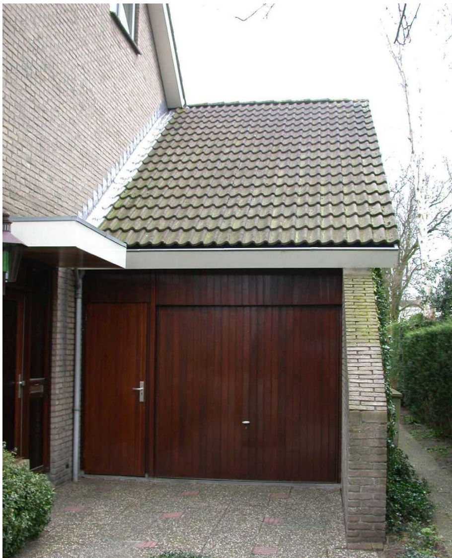
Zijgevel westzijde, Wilthoeflaan 19 Oegstgeest
