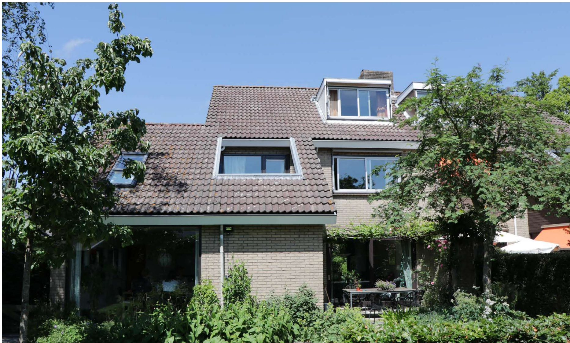
Achtergevel zuidzijde, Wilthoeflaan 19 Oegstgeest
