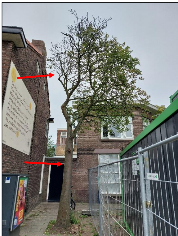
De boom is middels rode pijl gemarkeerd. De top is grotendeels afgestorven
