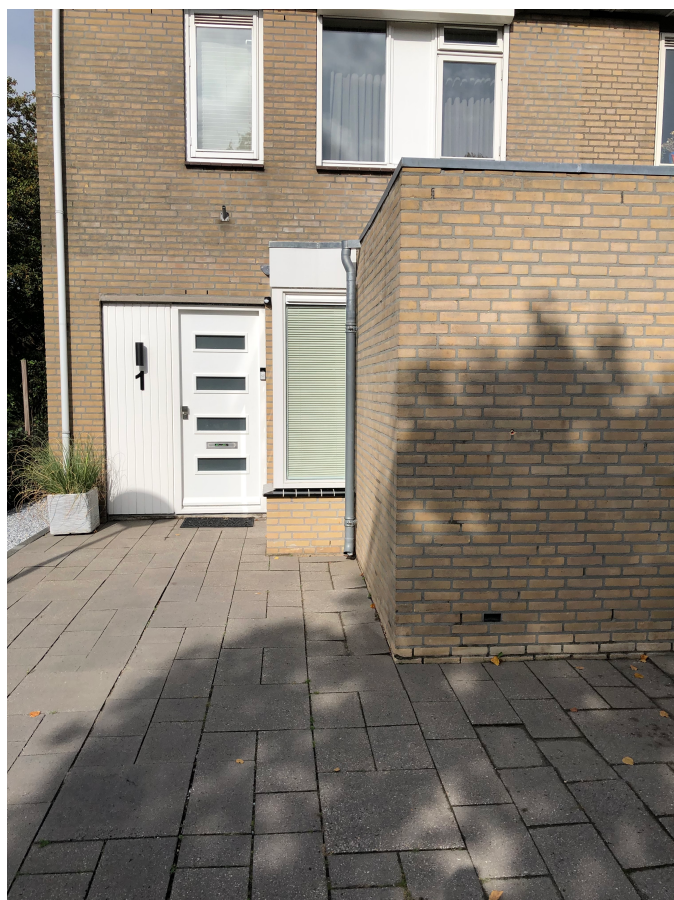
Flipselaan 1 reeds gerealiseerde uitbouw
