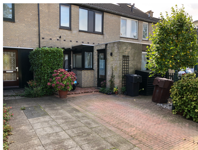
E. van Beinumlaan 5 reeds gerealiseerde uitbouw
