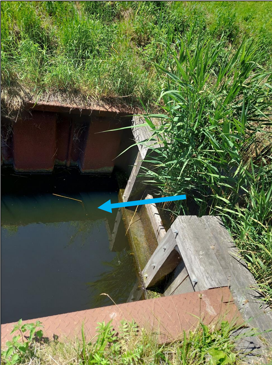
Figuur 6: Stuw langs de A.C. de Graafweg (N241) nabij de boerderij. Peilen zijn -1.60 m NAP en -1,95 m NAP, in blauw de stroomrichting.
