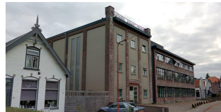
Transformatie monumentaal pand naar begeleid wonen – Stationsweg, Heerenveen 2
