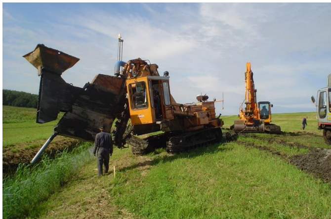
Aanleg drainage binnenzijde primaire kering
