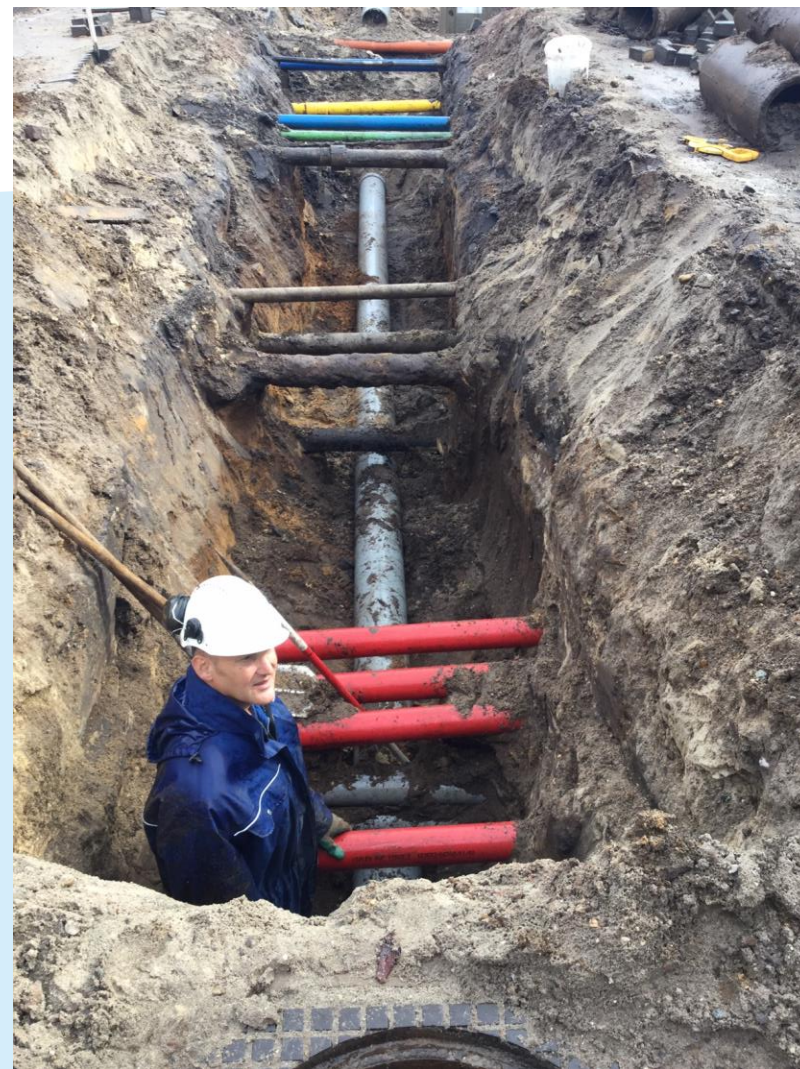
Foto: Aanleg riolering wethouder Sandersstraat – Poelkampstraat (Eerbeek) Werkzaamheden riolering Eerbeekse Enk met overige aanwezige nutsvoorzieningen
