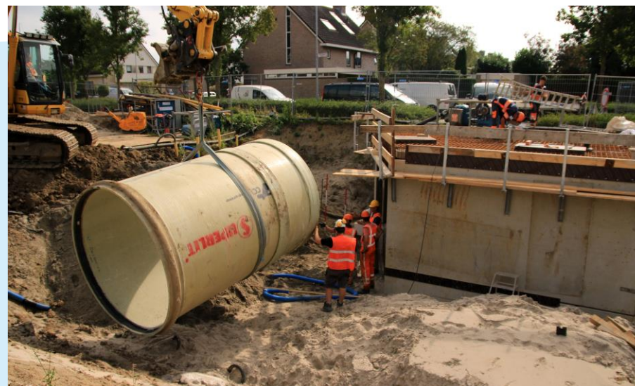
Foto: aanleg bergingsleiding vuilwater bij hemelwaterretentie wijk Elzenbos (Brummen)
