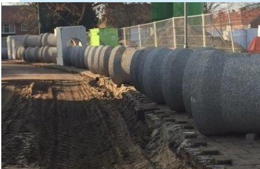
Foto: aanleg IT-riool
