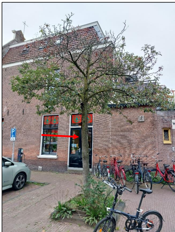
Boom 2036785 is middels rode pijl gemarkeerd. De top is volledig afgestorven.
