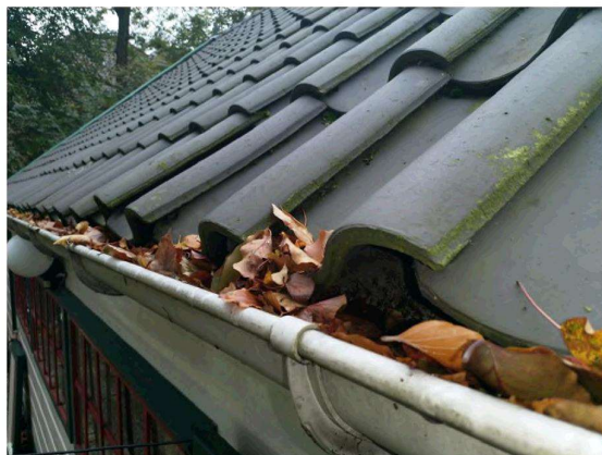
Holte achter de dakpannen. Toegang via de dakgoot. Foto: [REDACTED] | Ecoresult B.V.
