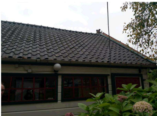
Impressie van het dak van de garage. Ruimte en toegang tot ruimte onder het dak via de dakgoot, achter de groene balk en onder de nokpannen. Foto: [REDACTED] | Ecoresult B.V.
