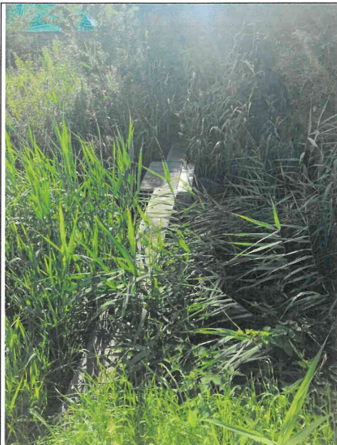
NOOIJ04.2 Situatie rondom de stuw, kijkend vanaf het fietspad.
