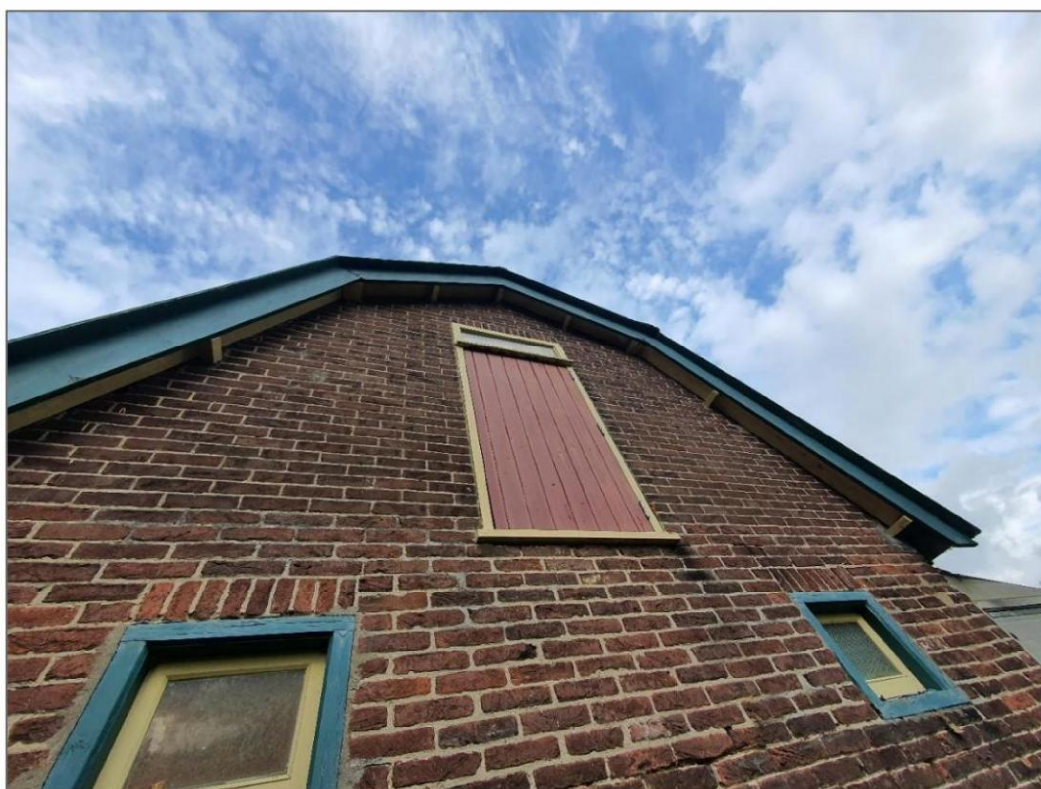
Dakrand woning achterzijde
