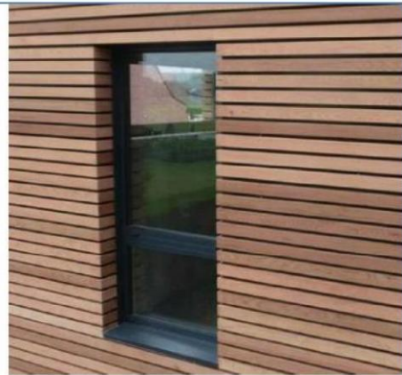
Uitkraging hoek gevel
