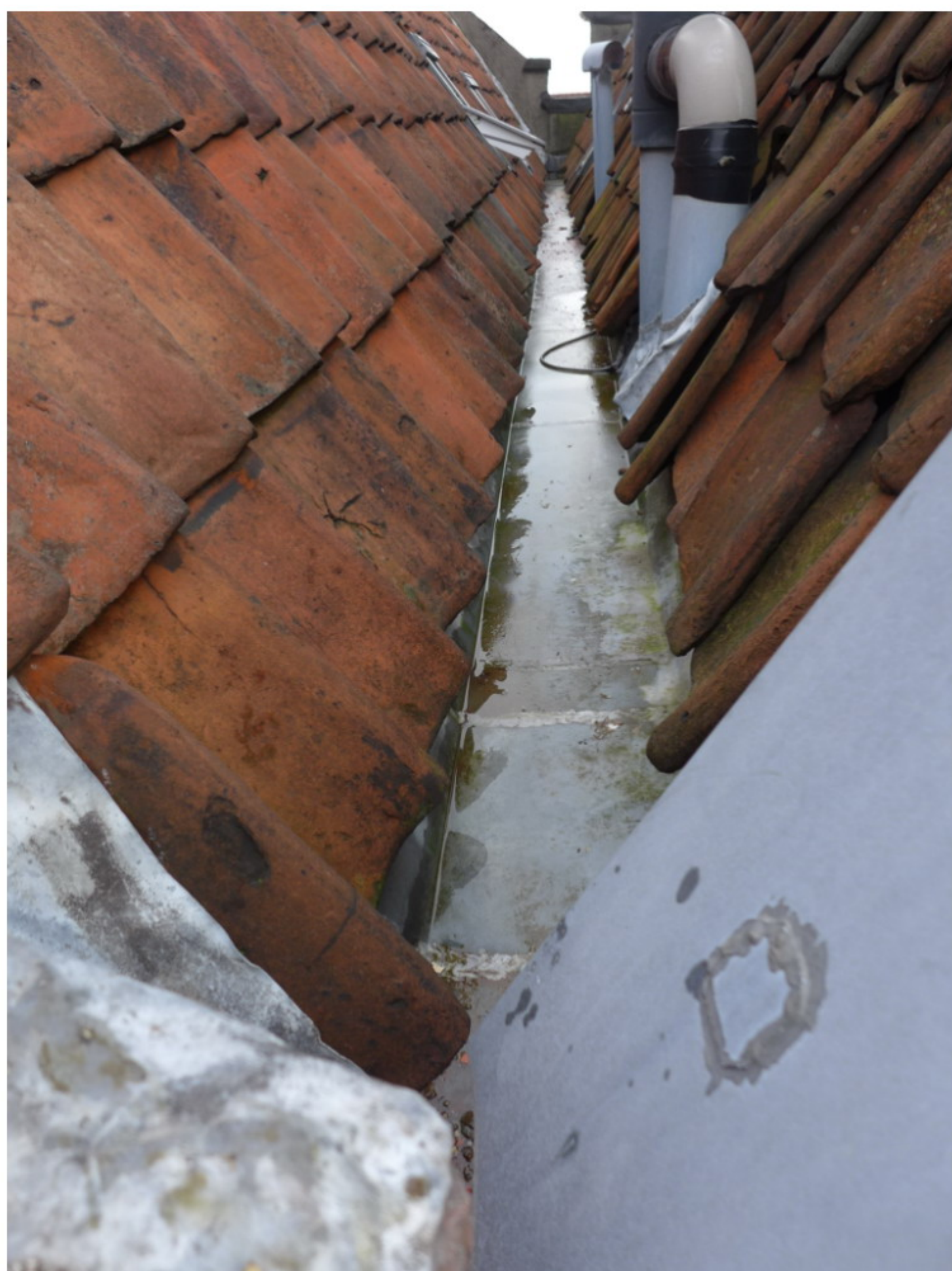
5 linker goot vanaf achter gezien
