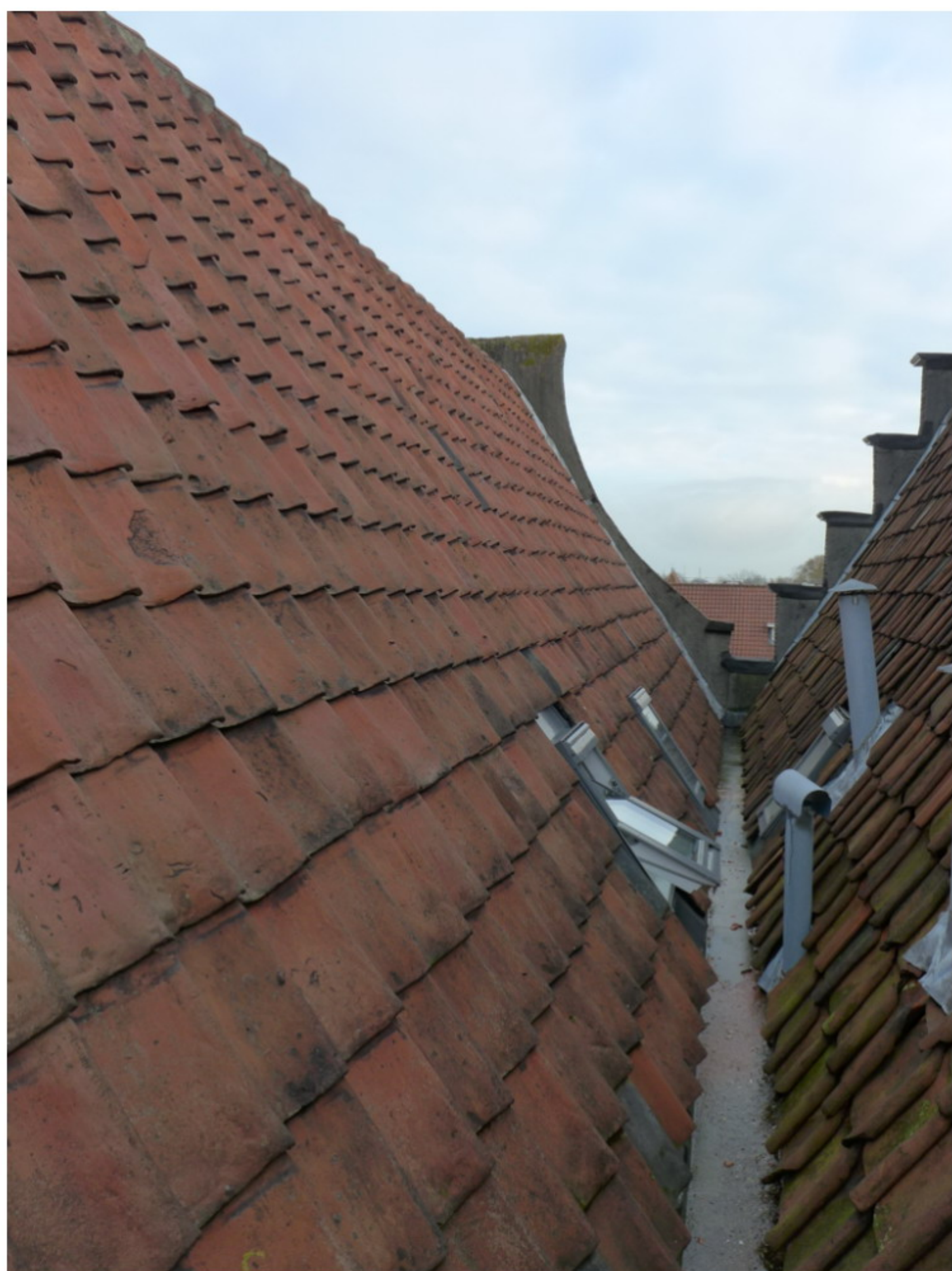
7 linker goot vanaf achter gezien
