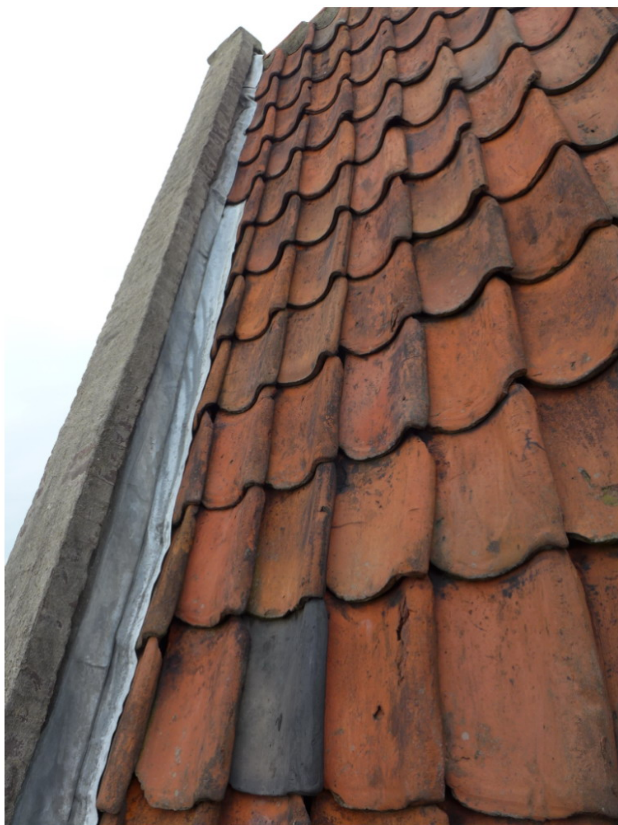
11 opstand achtergevel linker goot
