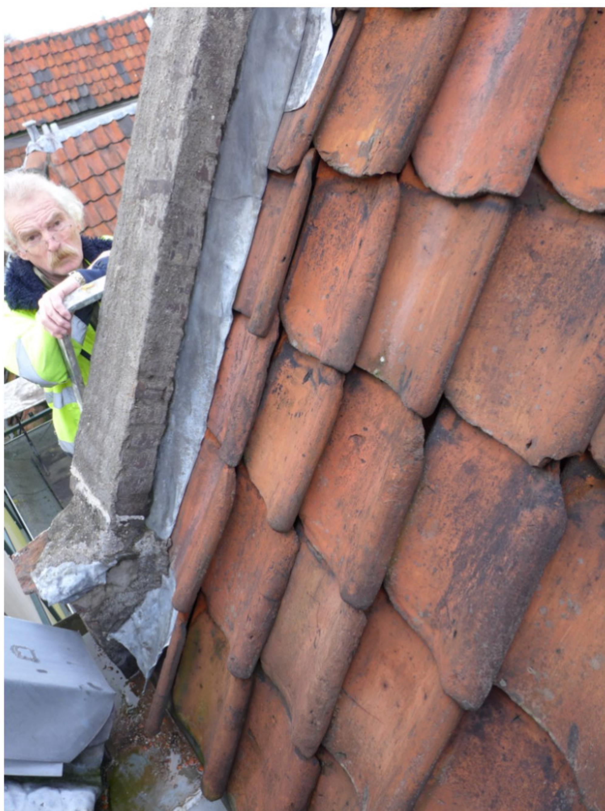
10 opstand achtergevel linker goot
