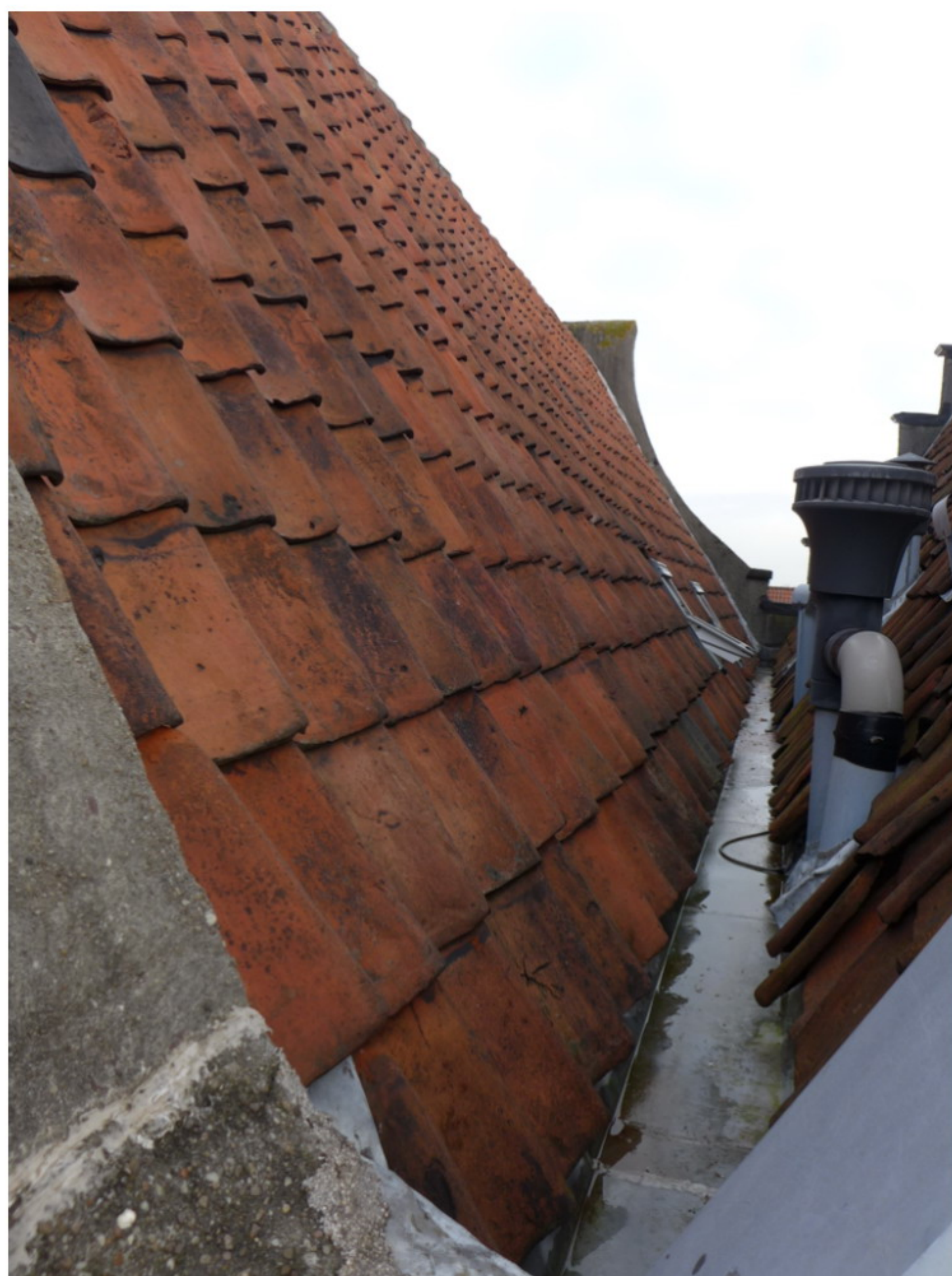
6 linker goot vanaf achter gezien
