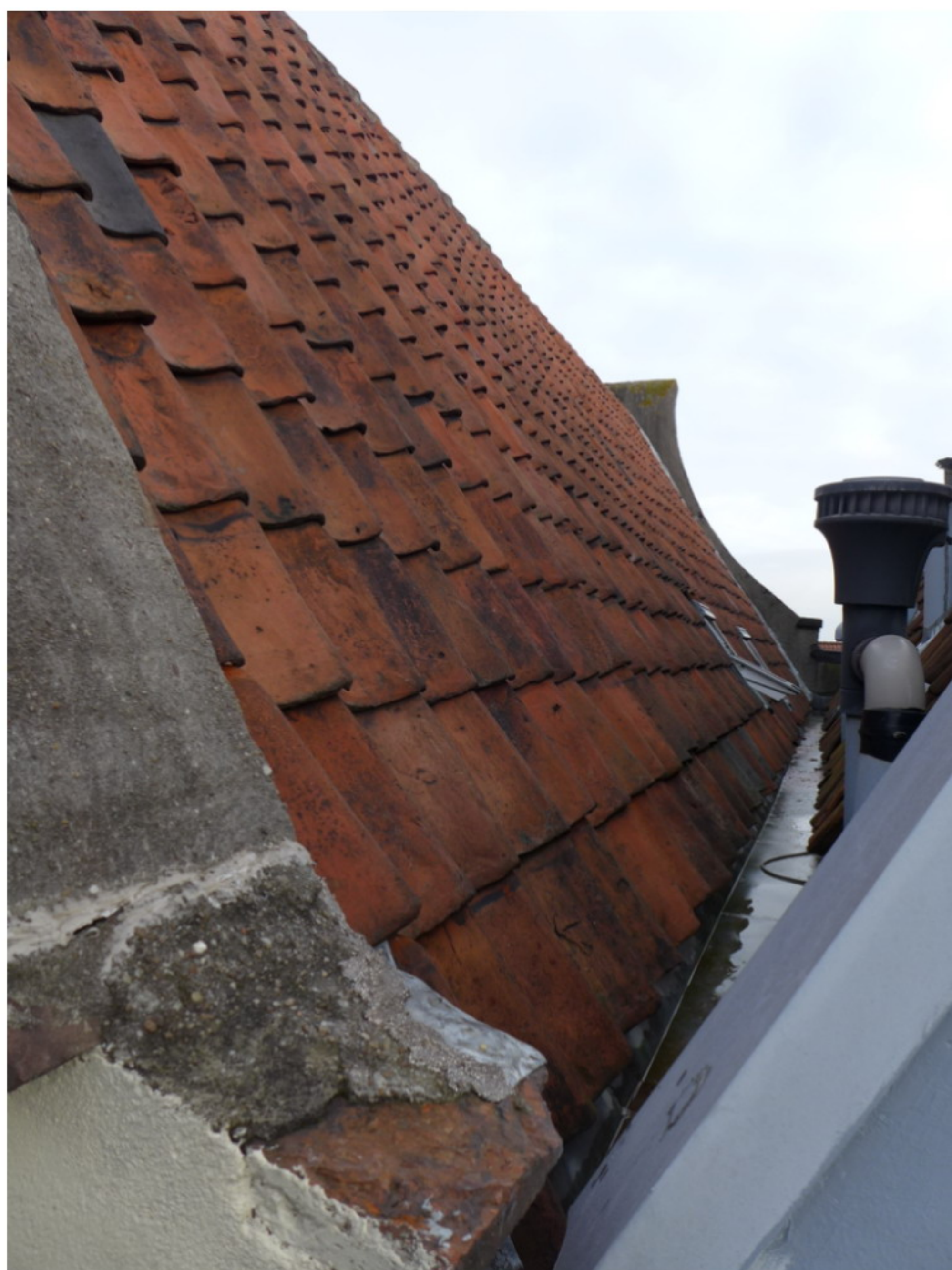
3 linker goot vanaf achter gezien
