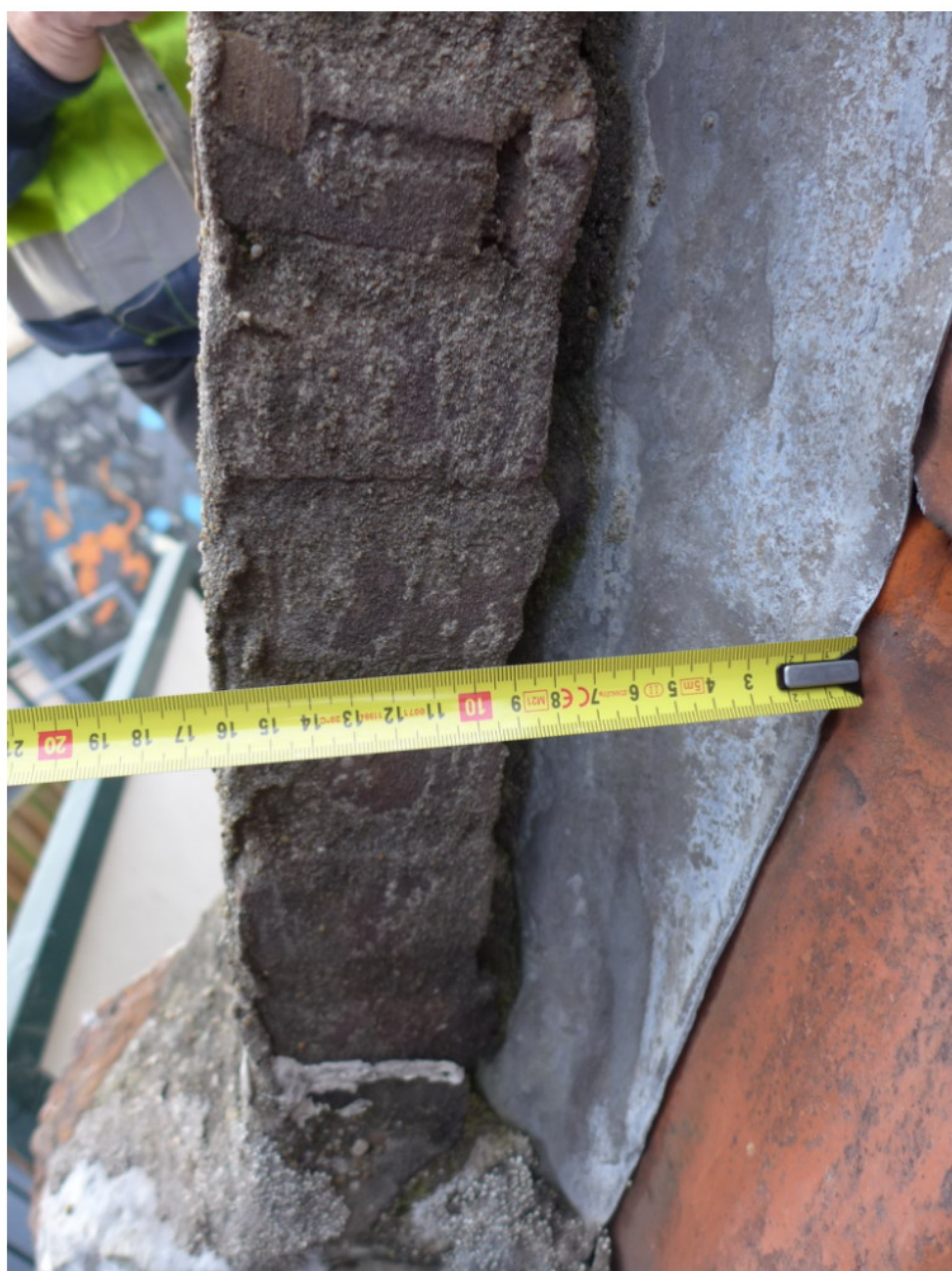
9 opstand achtergevel linker goot
