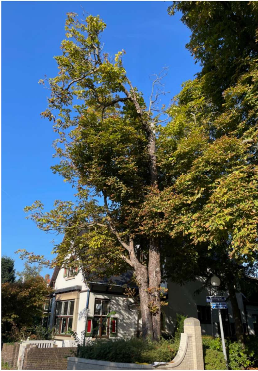
Foto 1: Overzicht boom 2 met gebroken top
