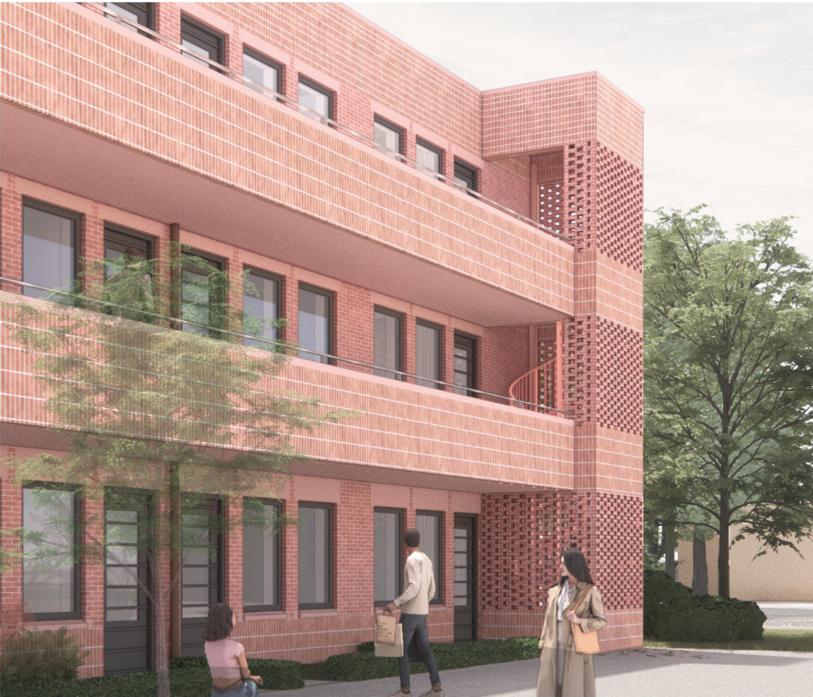
Dakrand boven galerij (noordgevel)
