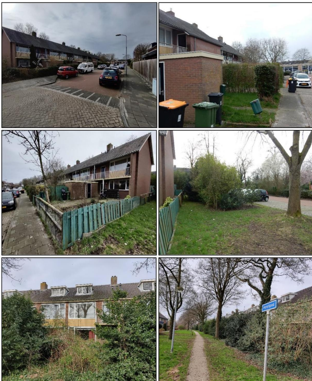
Afbeelding 2. Indruk van het plangebied. Bovenste rij: foto's van de voorzijde van de panden in westelijke richting; middelste rij: voorkant van de panden in oostelijke richting en het hoekpand; Onderste rij: achterzijde van de panden en het wandelpad aan de achterzijde van de woningen. (foto's: Laneco, 2021).
