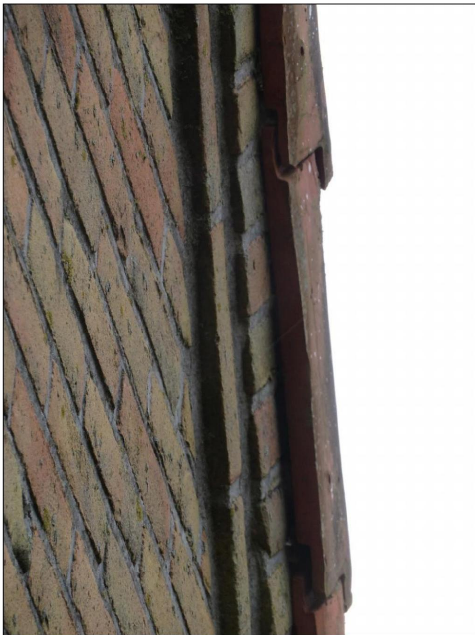
Afb 14: Kantpannen sluiten strak aan op de gevels
