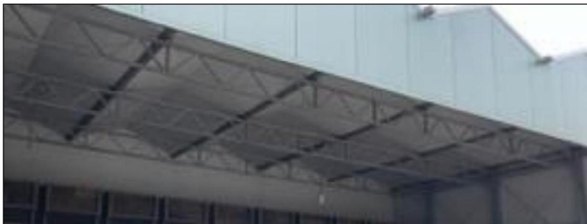
Afb 15: Open kap goed controleerbaar, geen nesten aanwezig
