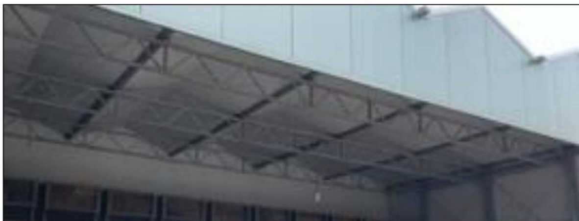
Afb 15: Open kap goed controleerbaar, geen nesten aanwezig
