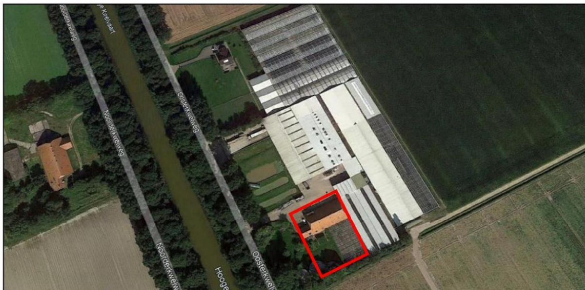
Afb 2: In het rode kader de te slopen woning met schuur + glazen kas
