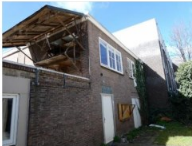
Figuur 2.3 Achteraanzicht van de onderzoekslocatie.
