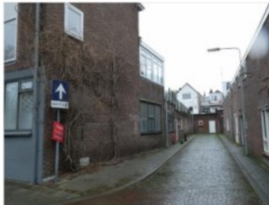
Figuur 2.4 Zijaanzicht van de onderzoekslocatie.
