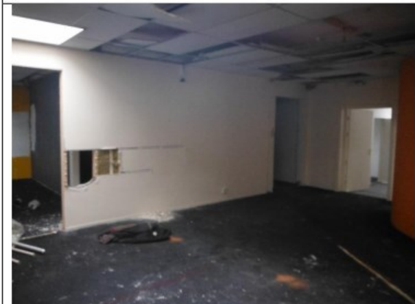
Vanuit noordwestelijke richting nabij boring 2
