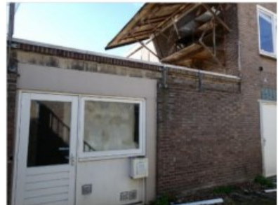
Figuur 2.5 Achteraanzicht van de onderzoekslocatie.
