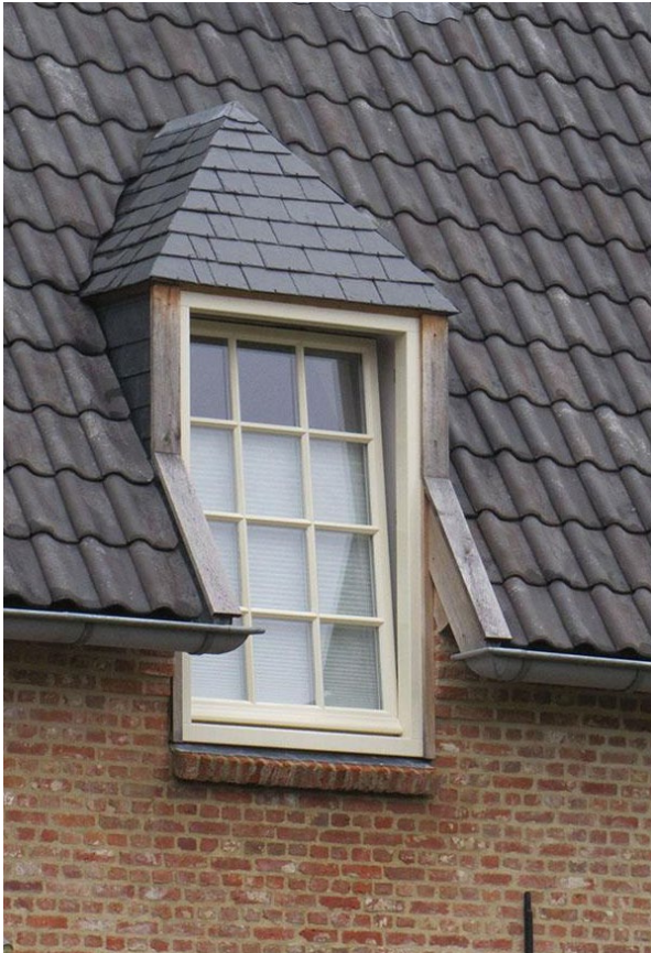
raamdorpel van baksteen; zinken mastgoot; kozijn met roeden
