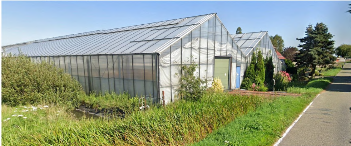
Fig. 3.2 Aanzicht vanaf de Tuinbouwweg, met de (inmiddels gesloopte) kassen
