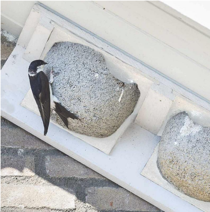
Figuur 12 Permanente voorziening huiszwaluw; neststenen.
