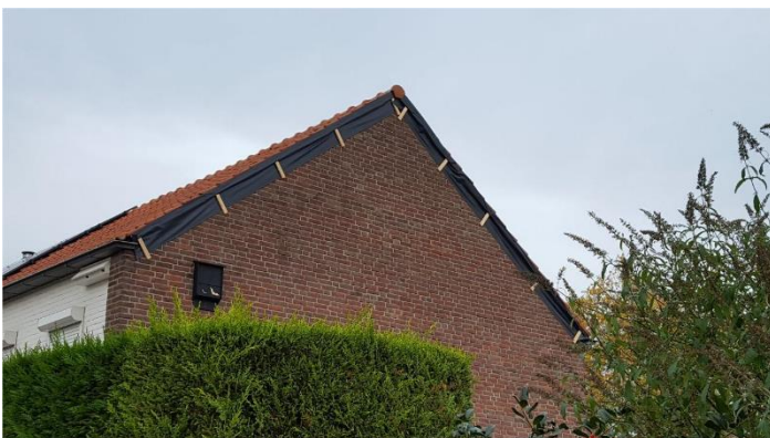
Figuur 15 Ontmoediging kopgevel met exclusion flap.
