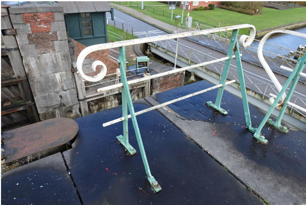
Figuur 134. Hekwerk met geklonken verbindingen. De krullen van de bovenligger zijn bij de hekken op de zuidelijke frontmuur forser dan bij de noordelijke frontmuur.
