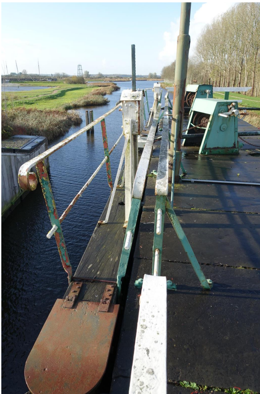
Figuur 126. Overzicht van de hekjes op de noordelijke vloeddeur.
