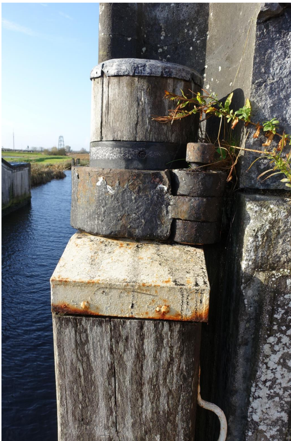
Figuur 125. Detail gesmede strop rond de achterhar van de noordelijke ebdeur.
