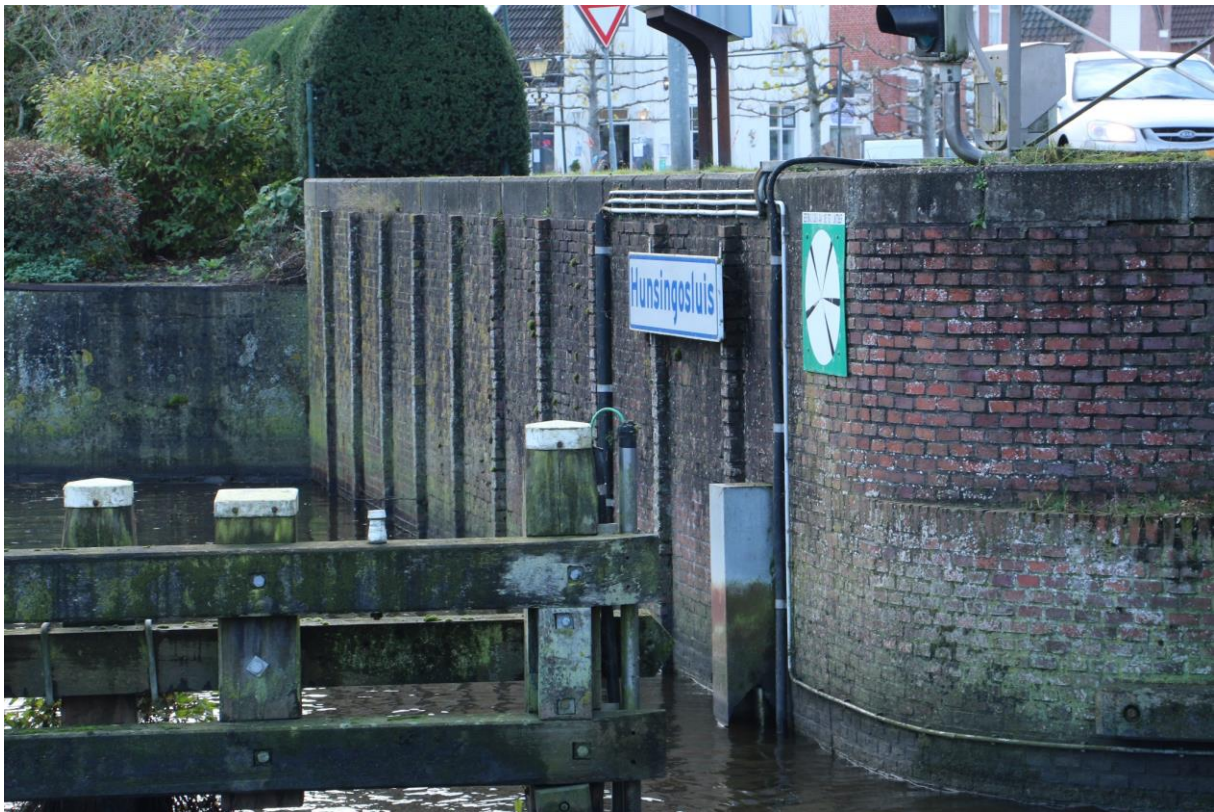
Figuur 151. Aansluitend op het oostelijke uiteinde van het zuidelijk brughoofd werd ook de kademuur vernieuwd.
