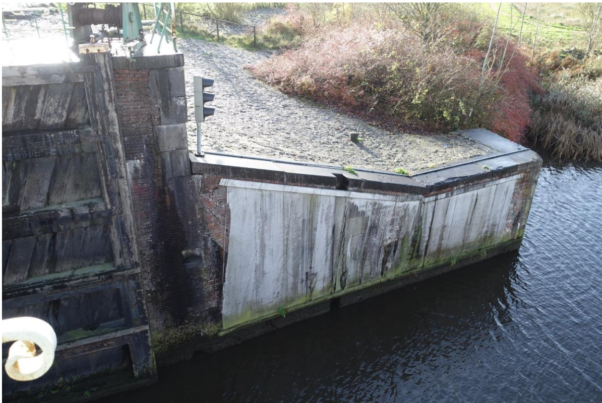
Figuur 107. Overzicht zuidwestelijke vleugelmuur.
