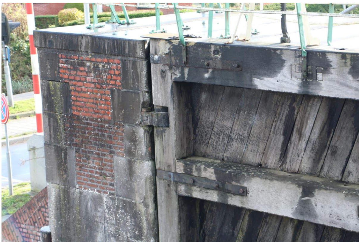
Figuur 127. Detail bovenhoek van de uit 1966 daterende zuidelijke vloeddeur.
