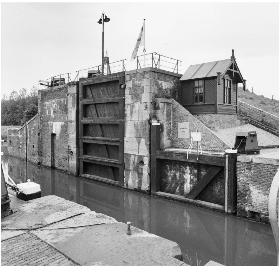
Figuur 71. Overzicht noordelijke sluiswand op 25 juni 1991. Bron: RCE, nr. 287.017, A.J. van der Wal.
