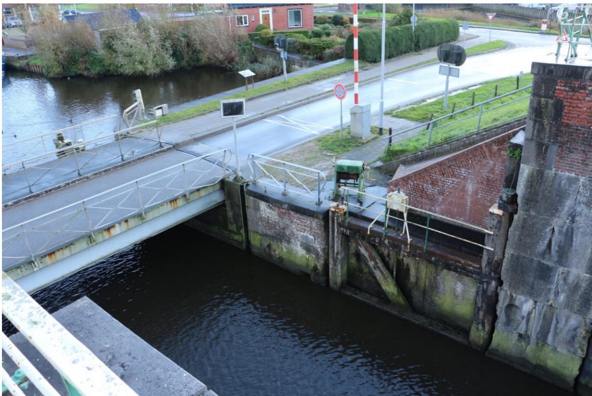
Figuur 93. Aansluiting van de in 1981 vernieuwde en verbrede brug op de zuidelijke sluiswand.
