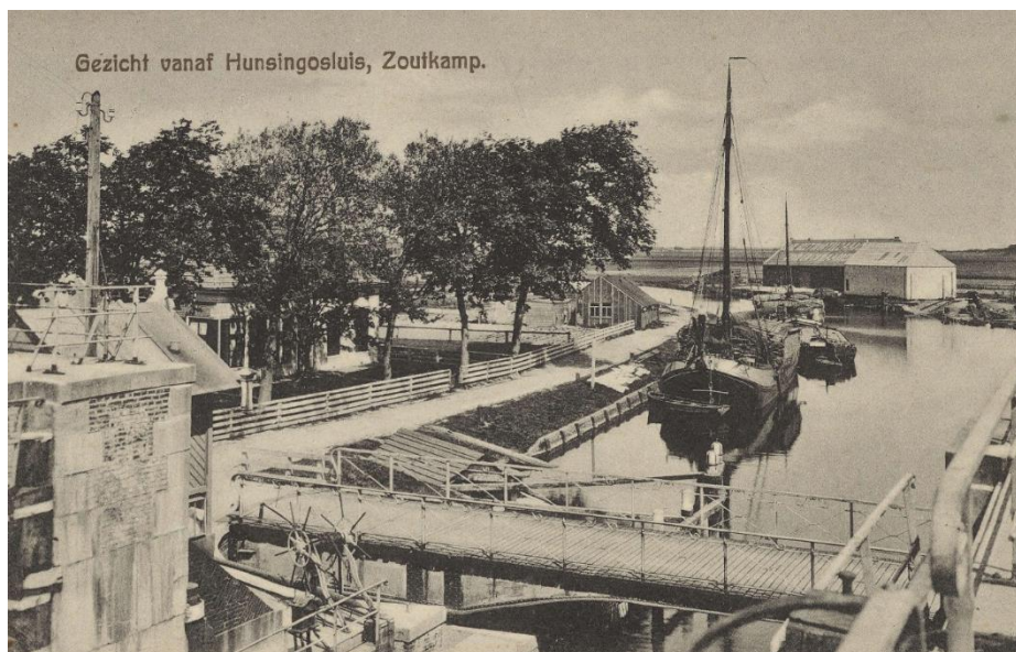
Figuur 59. Dit fraaie zicht over de sluis omstreeks 1925 toont goed de vernieuwde brug. Linksonder is nog de kaapstander van de ebdeur zichtbaar. Bron: GA, nr. 1986_20388, uitgave B. Oosterhoff.
