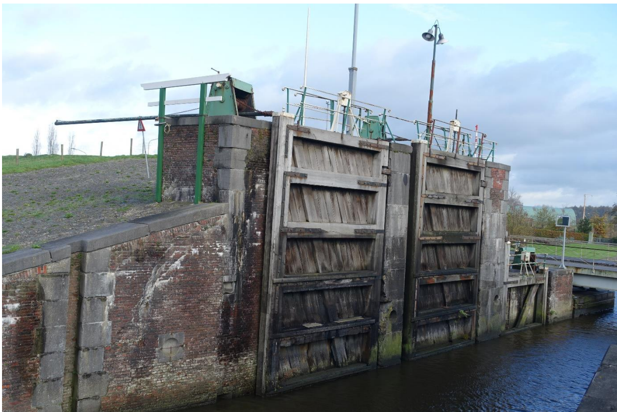
Figuur 95. Overzicht noordelijke sluiswand.
