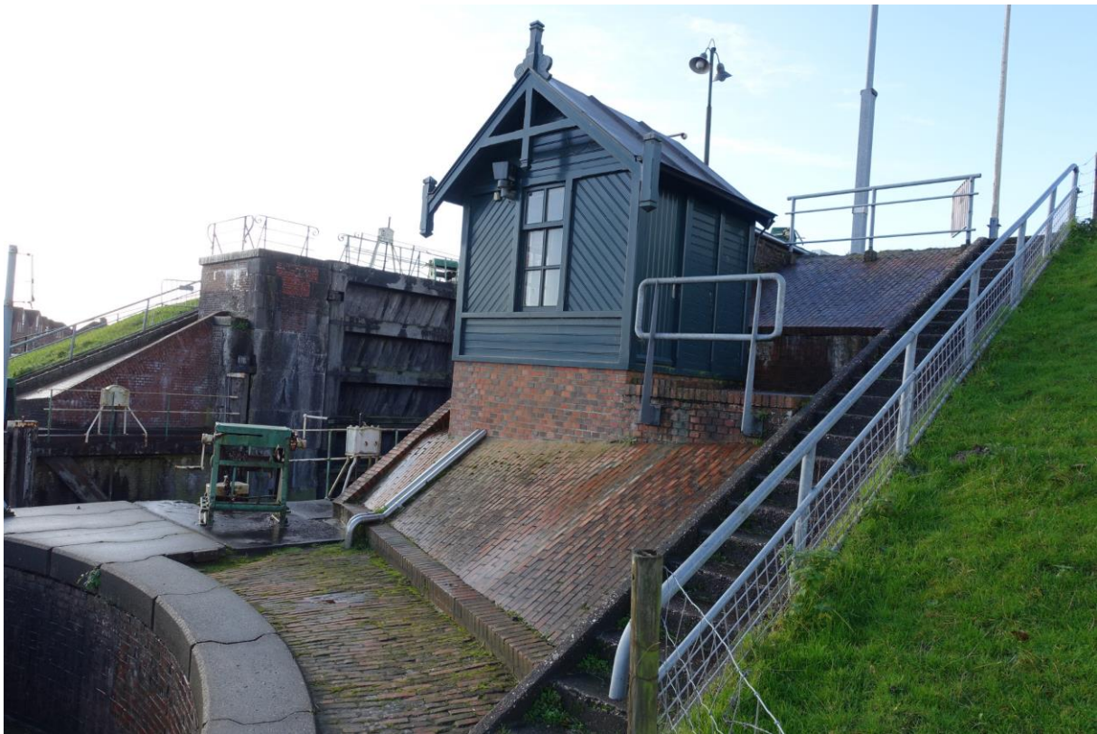
Figuur 118. Overzicht noordoostelijk talud met hierop sinds ca. 1900 aanwezig sluiswachtershuisje.
