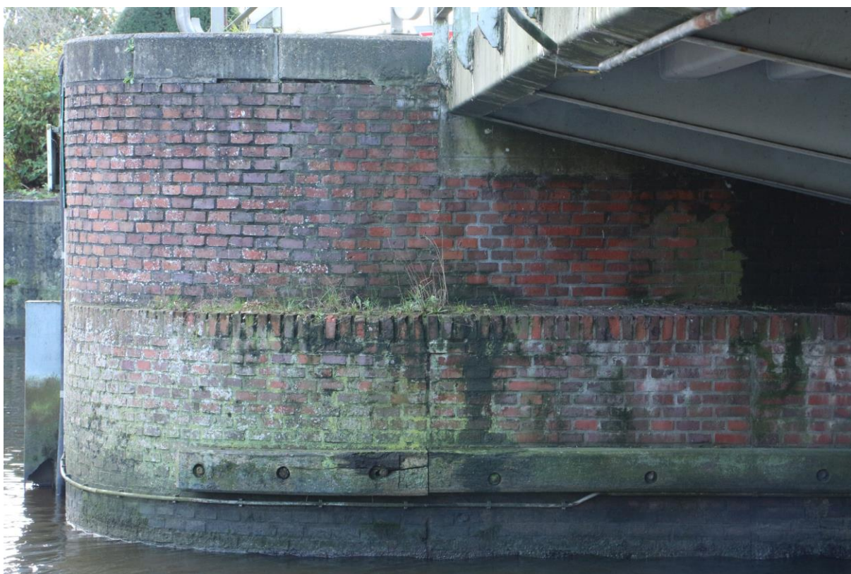
Figuur 150. De brughoofden werden bij de verbreding en vernieuwing van de brug in 1981 verlengd, waarbij deze ronde hoek tot stand kwam.
