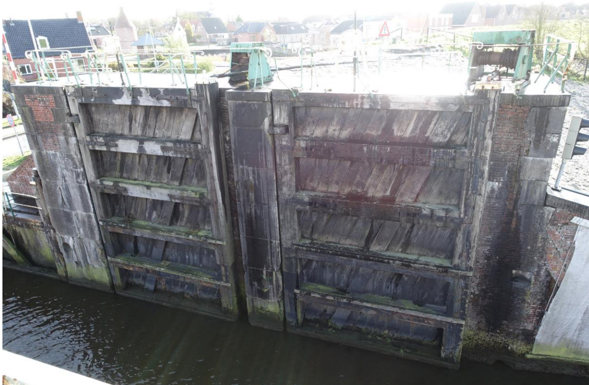
Figuur 101. Overzicht sluiszijde van de zuidelijke frontmuur
