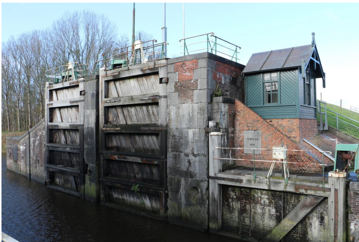
Figuur 128. Overzicht noordelijke sluisdeuren.
