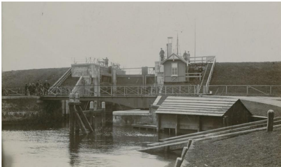
Figuur 57. Zicht op de Hunsingosluis, kort na de vernieuwing van de brug. Hier is op de zuidoosthoek van de brug een smalle, wat langere aanbrug aanwezig. Deze lijkt op hierna volgende foto al te zijn ingekort, met aansluitend een (op dat moment vrij nieuwe) kademuur met diagonaal uitspringende penanten. Bron: GA nr. 818_18798 P.B. Kramer.
