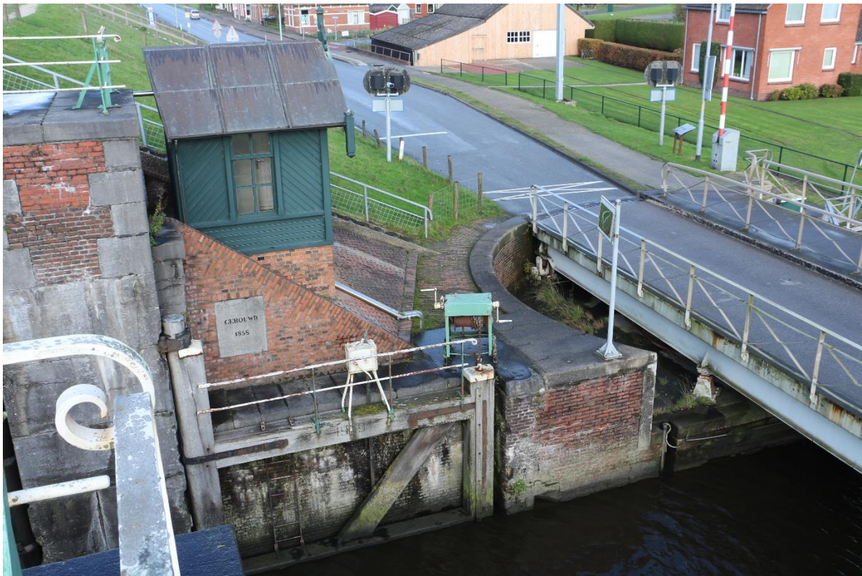
Figuur 94. Aansluiting van de brug op de noordelijke sluiswand.
