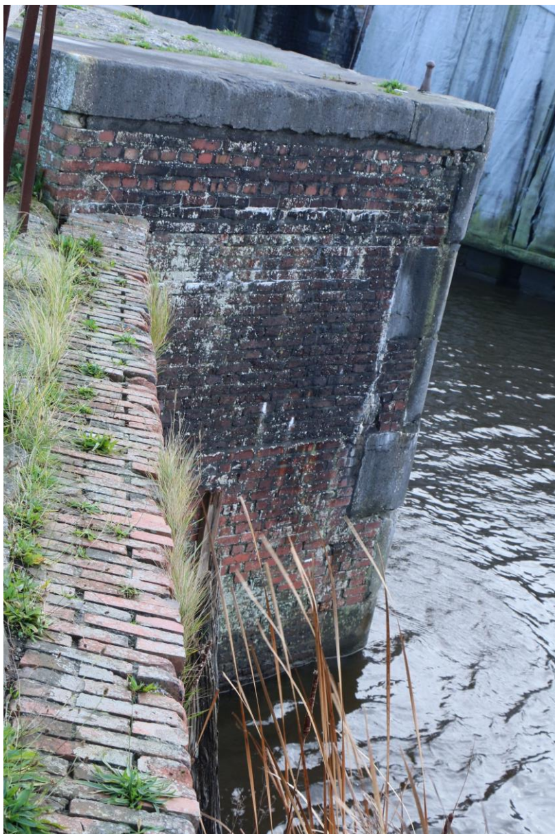
Figuur 106. Westzijde van de noordwestelijke vleugelmuur.
