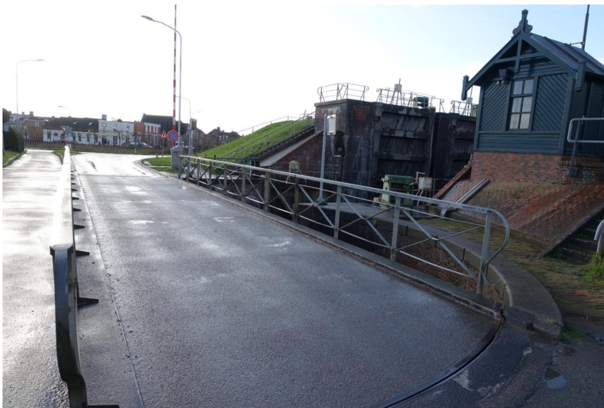
Figuur 86. Zicht over de brug, met rechts het aansluitende deel van de sluis.
