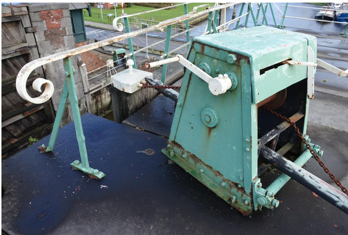
Figuur 144. De kaapstander van de zuidelijke vloeddeur komt overeen met de kaapstanders op de noordelijke frontmuur.
