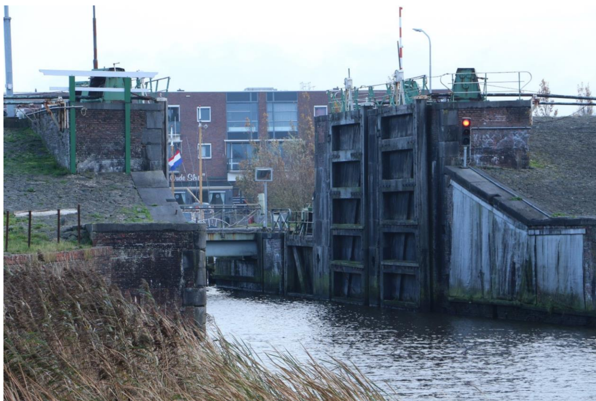
Figuur 96. Westzijde van de sluis.
