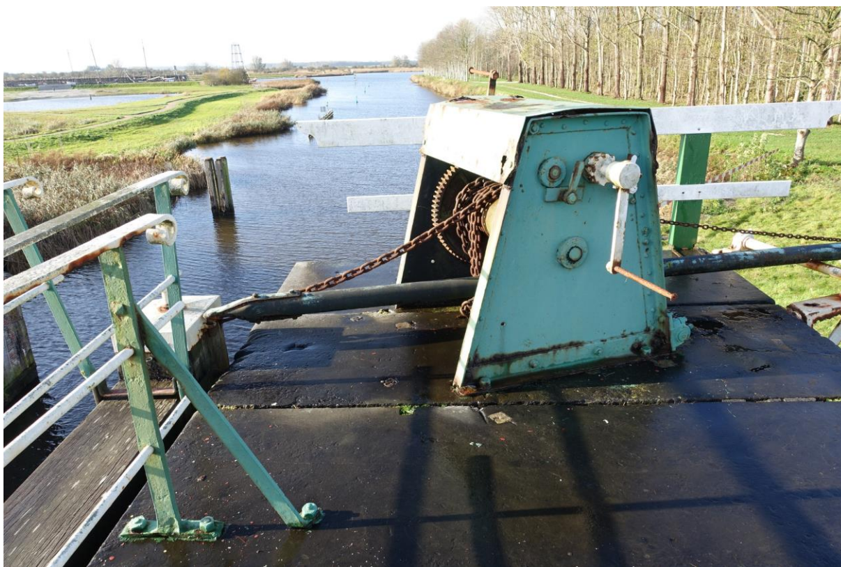
Figuur 140. Detail van één van de twee kaapstanders met geklonken verbindingen op de noordelijke frontmuur.
