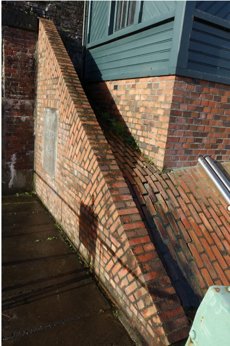
Figuur 120. In 1981 vernieuwde keermuur en onderbouw van het sluiswachtershuisje.
