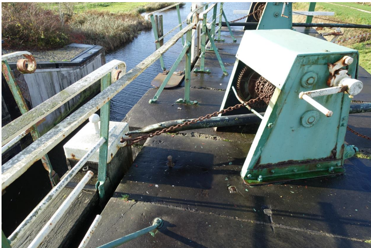
Figuur 132. Hekwerken met geklonken verbindingen langs de zuidzijde van de noordelijke frontmuur.
