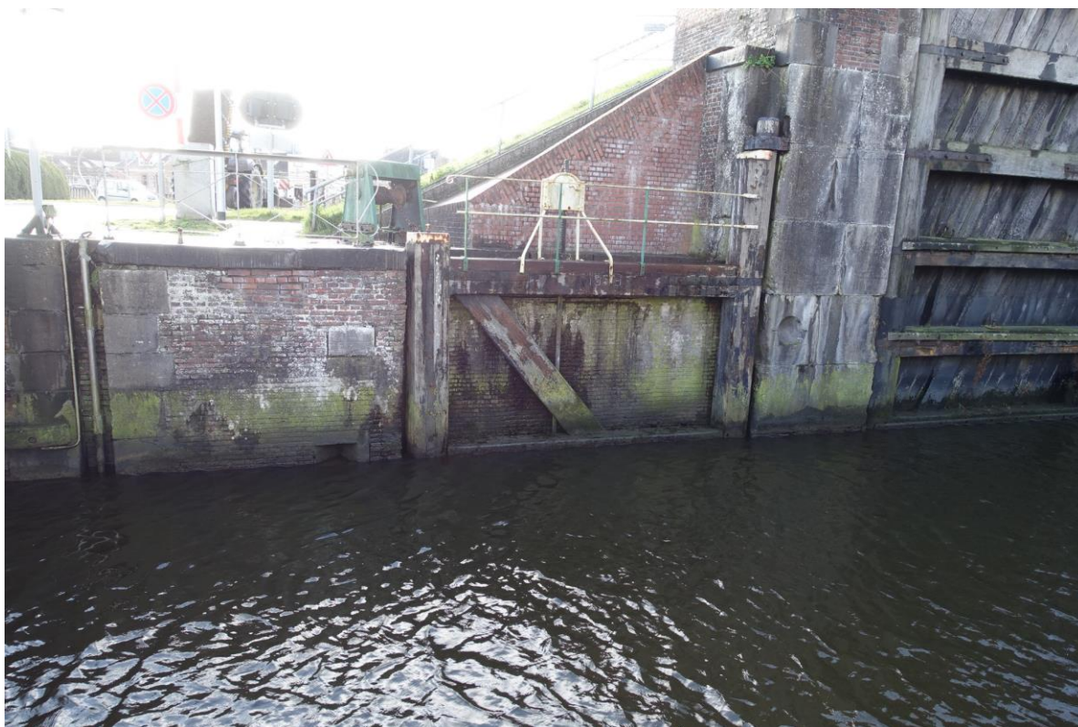
Figuur 116. Overzicht restant van de zuidoostelijke vleugelmuur, oorspronkelijk met dezelfde opzet als de noordoostelijke vleugelmuur.
