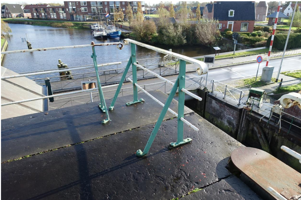
Figuur 131. Tot de eerste opzet (ca. 1900) behorend hekwerk op de zuidoosthoek van de noordelijke frontmuur.
