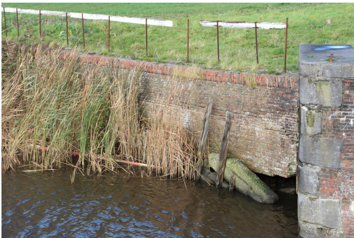
Figuur 154. Detail van de kademuur.
