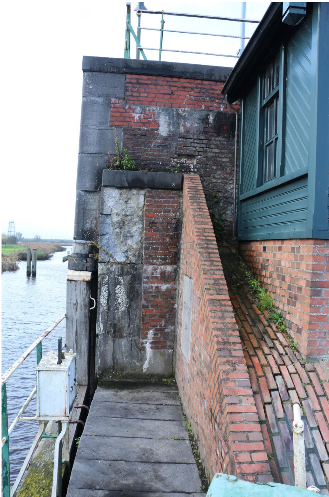
Figuur 114. Tegen de oostzijde van de frontmuur is nog een restant van het bovenste deel van de eerdere vleugelmuur bewaard. De oude traptreden zijn op de bodem herplaatst.
