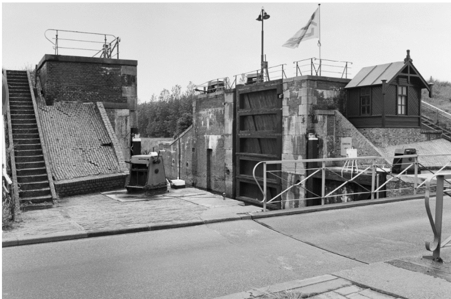
Figuur 70. Zicht op de sluis uit zuidoostelijke richting op 25 juni 1991. Bron: RCE, nr. 287.020, A.J. van der Wal.
