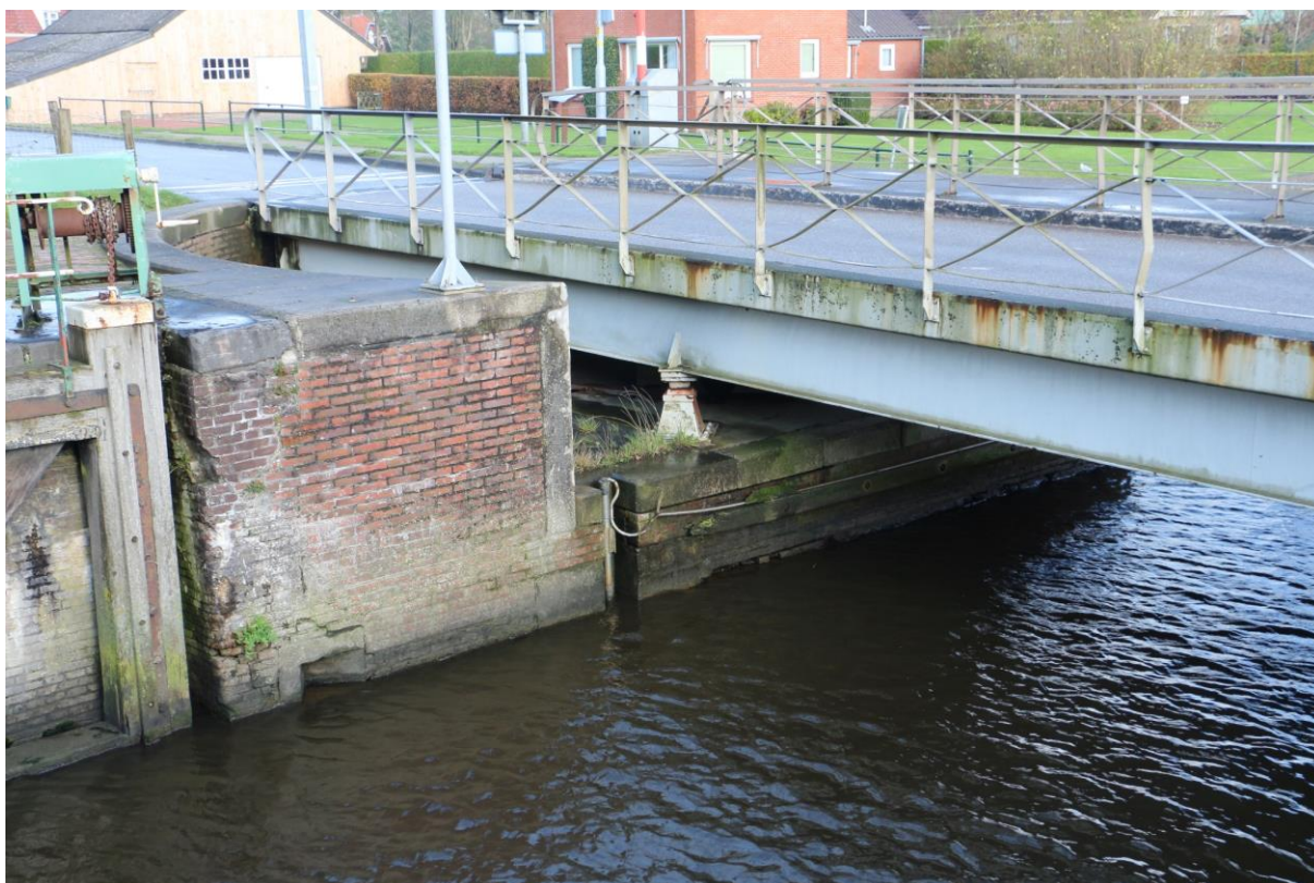
Figuur 113. Ter hoogte van de brug is alleen ter hoogte van de waterlijn nog ouder (1912) muurwerk aanwezig. De bovenzijde is hier in 1981 vernieuwd en deels aangevuld.
