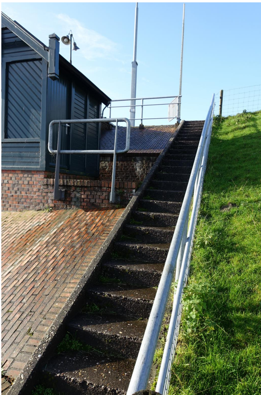
Figuur 121. Betonnen trap langs de noordzijde van het talud.
