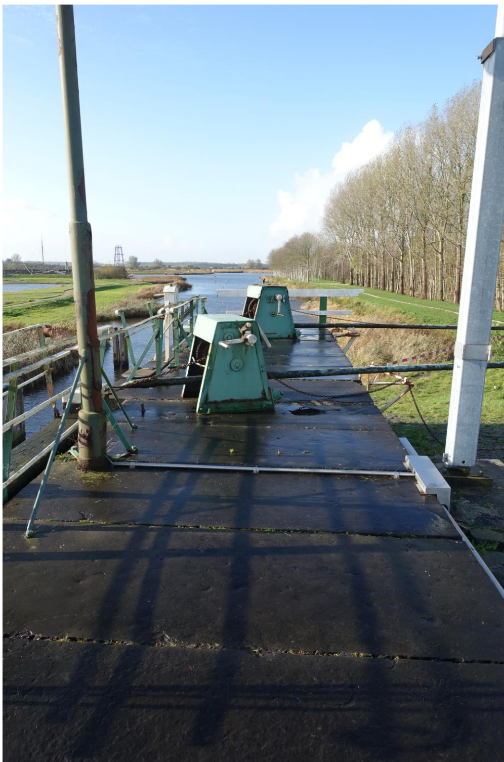
Figuur 98. Zicht over de noordelijke frontmuur in westelijke richting.
