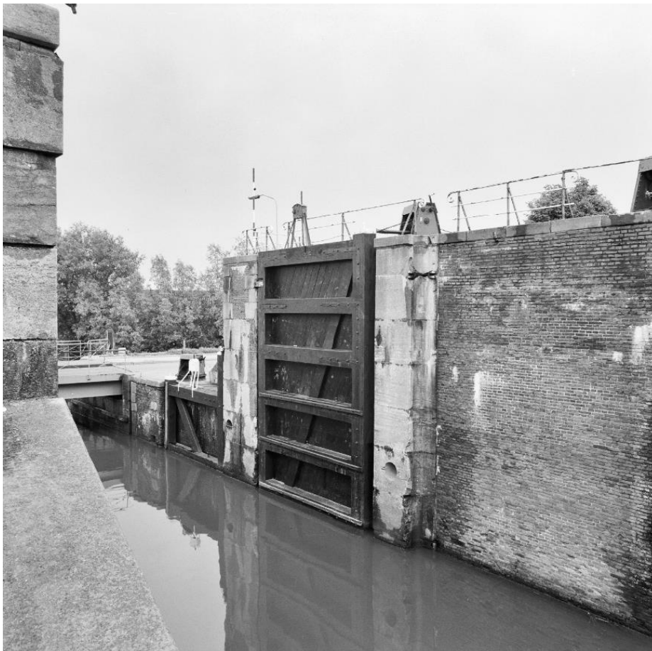
Figuur 72. Zicht richting de zuidelijke sluiswand. De vloeddeuren zijn in 1991 uitgenomen. Bron: RCE, nr. 287.015, A.J. van der Wal.
