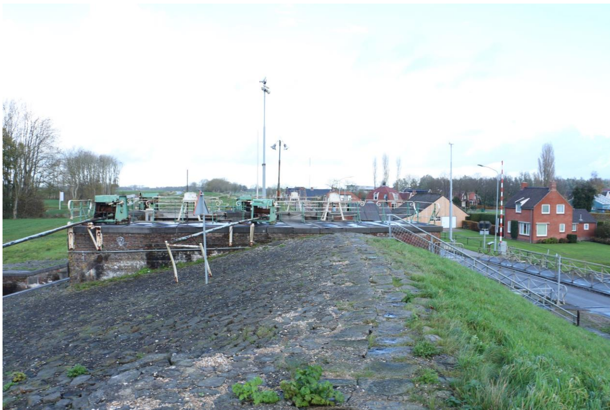
Figuur 149. Aansluiting van de dijk op de zuidelijke frontmuur, met ook hier een bekleding met basaltblokken op het buitentalud.
