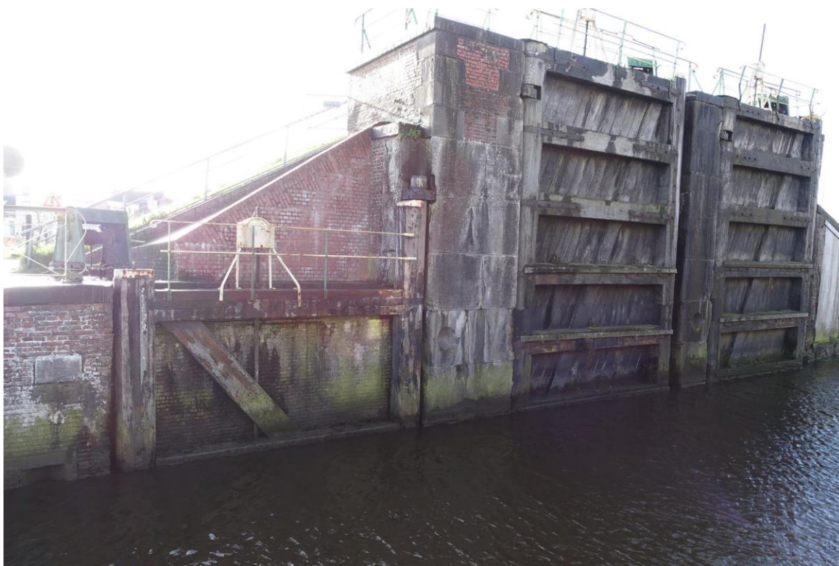
Figuur 124. Overzicht van de zuidelijke sluisdeuren, met van links naar rechts de ebdeur, de vloeddeur en de stormdeur.
