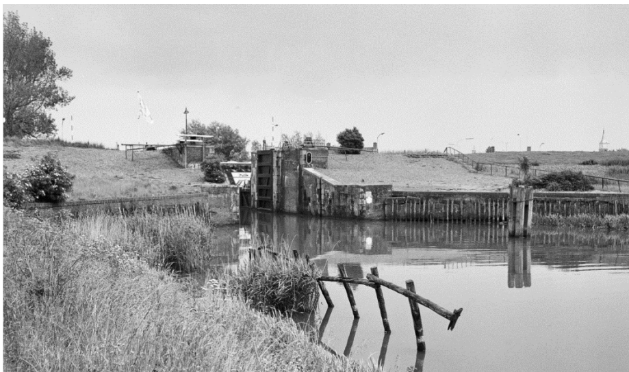
Figuur 76. Overzicht buitenzijde van de sluis op 25 juni 1991. Bron: RCE, nr. 287.023, A.J. van der Wal.
