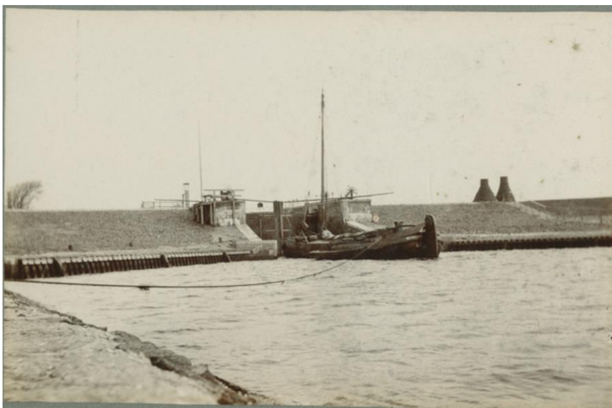
Figuur 51. Aanzicht van de buitenzijde van de Hunsingosluis, waarschijnlijk omstreeks 1900. Bron: GA, nr 818_18797.
