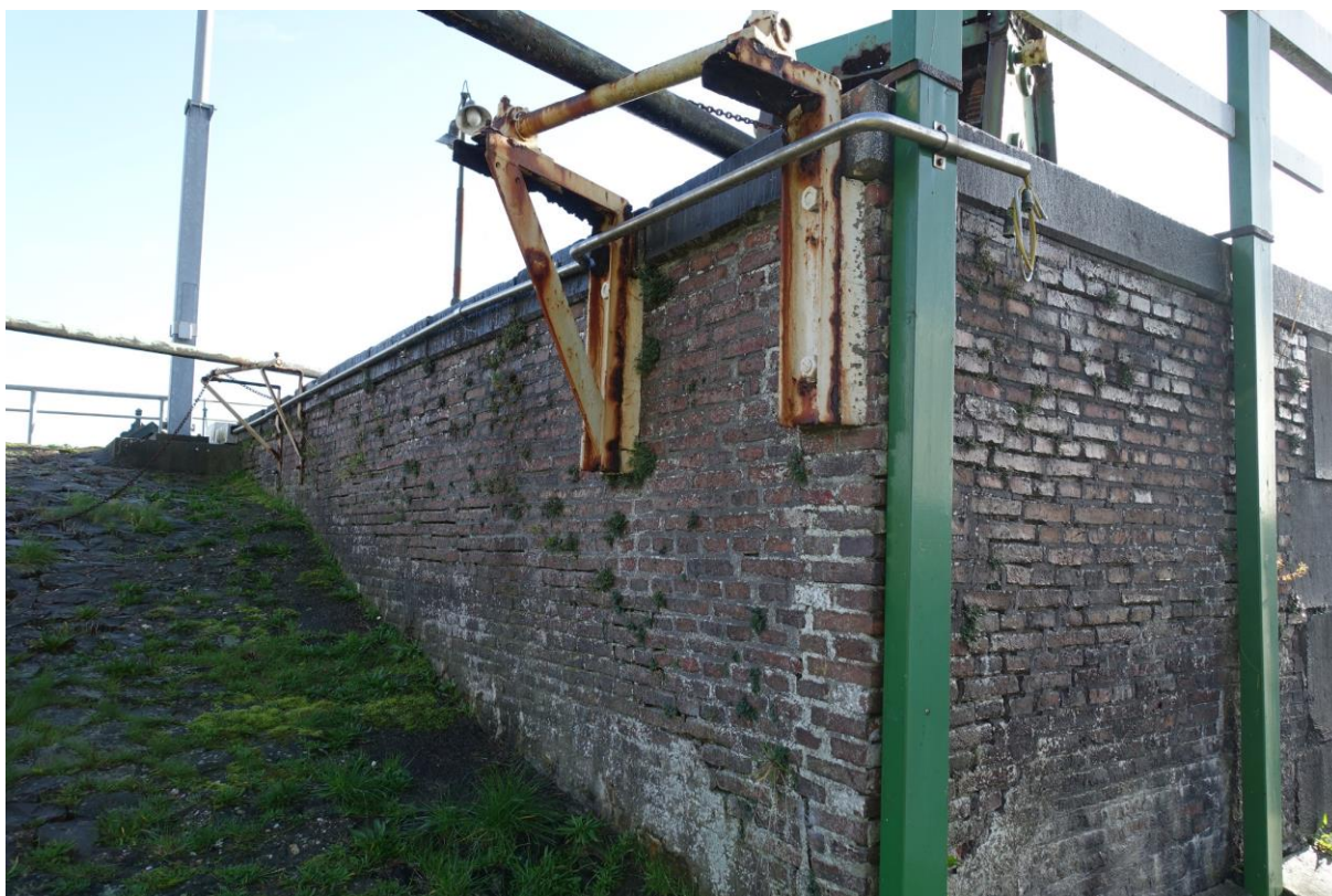
Figuur 141. Geleiderollen tegen de noordzijde van de noordelijke frontmuur.
