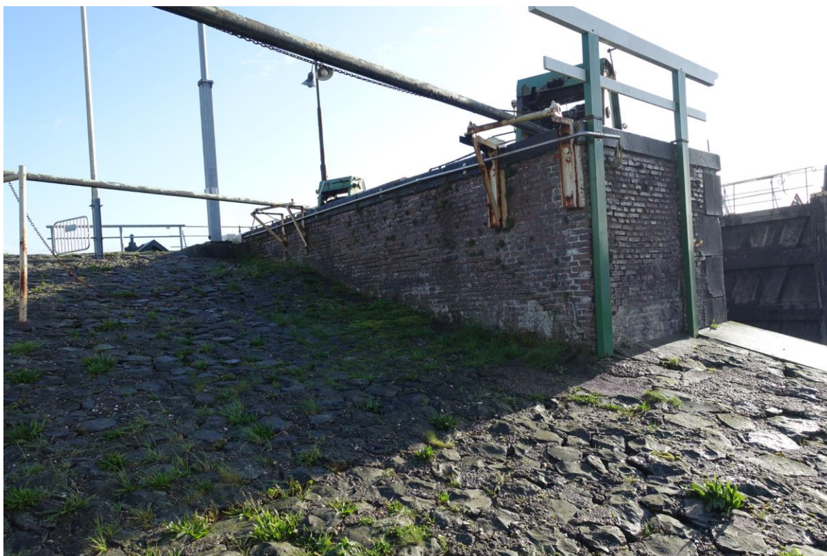
Figuur 148. Het buitentalud van de dijk, aansluitend op de beide frontmuren is met basaltblokken bekleed. Oorspronkelijk sloot hier gras aan op de sluis.
