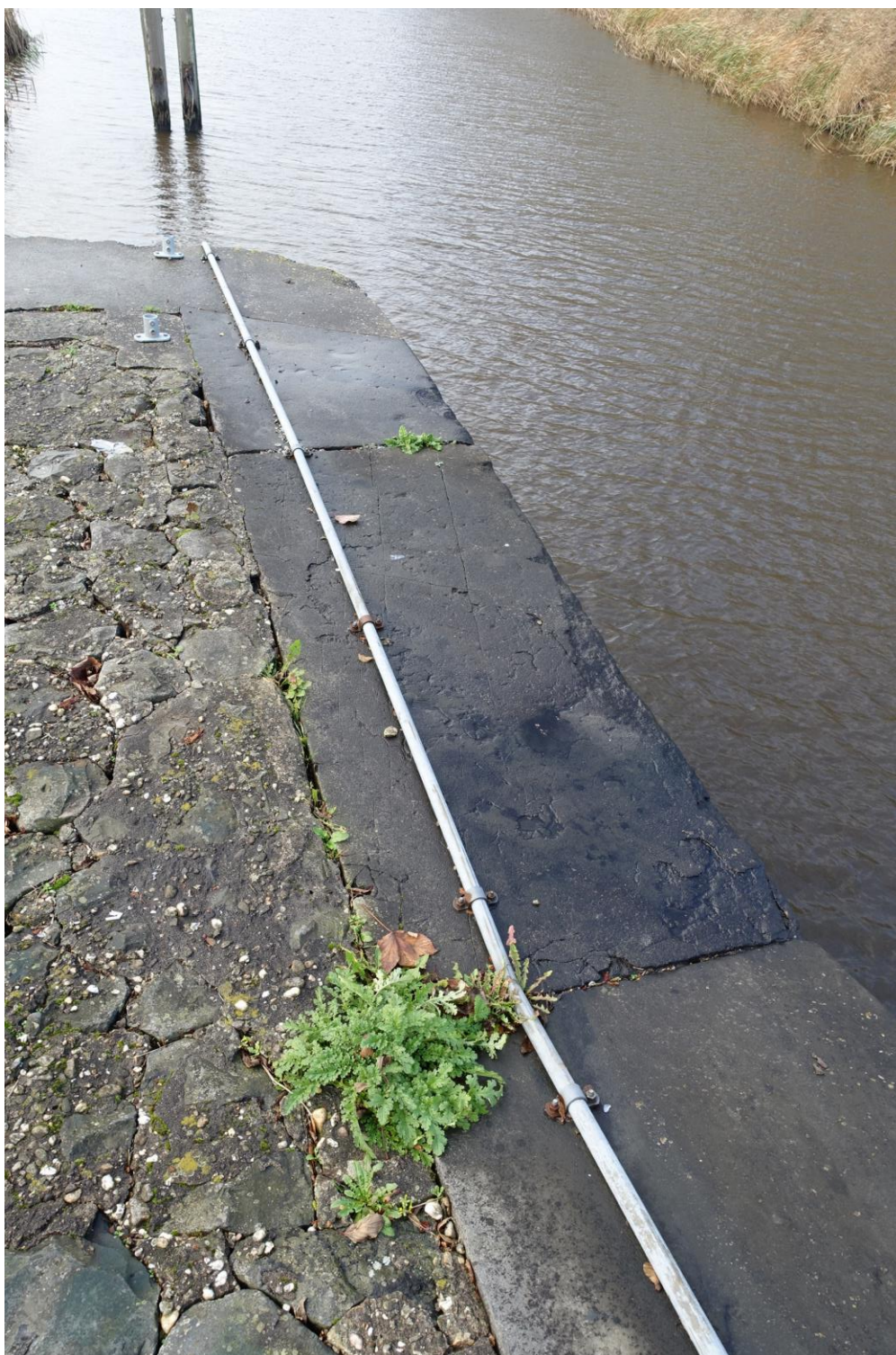
Figuur 110. Oorspronkelijke hardstenen afdekkingen op het vlakke deel van de vleugelmuur.
