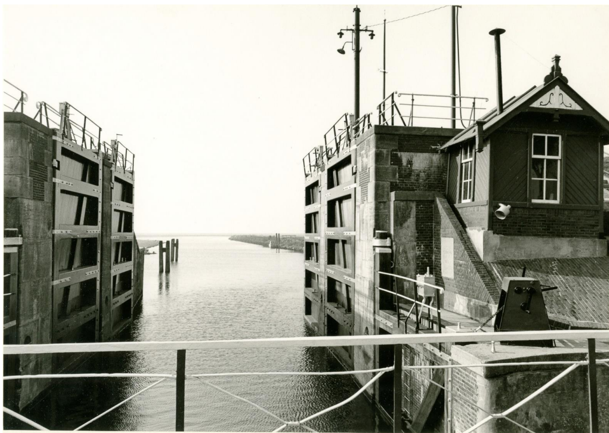
Figuur 64. Beeld van de sluis in 1972. Rechts is te zien dat de onderzijde van het sluiswachtershuisje is vervangen door metselwerk. Bron: GA, nr. 818_18608 , M.A. Douma.
