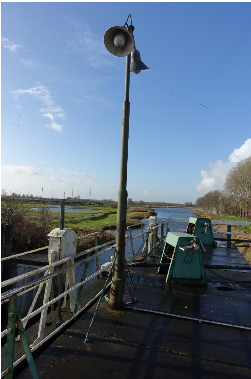
Figuur 136. Oudere lichtmast op de noordelijke frontmuur.
