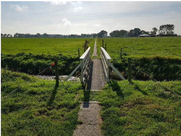
Foto 76: Situering bruggetje Panserpad
