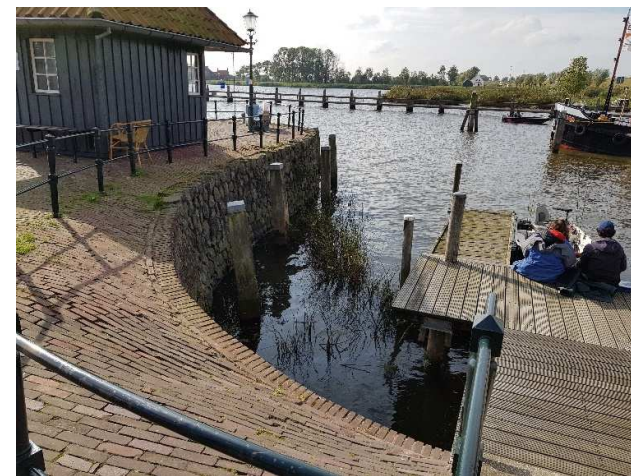
Foto 9: Situering aanmeervoorzieningen Reitdiep haven
