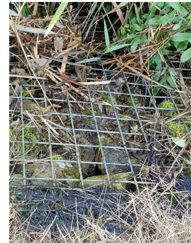
Foto 54: Situering uit te breiden aanlegplaatsen Hunsingokanaal (schanskorf beschoeiing)
