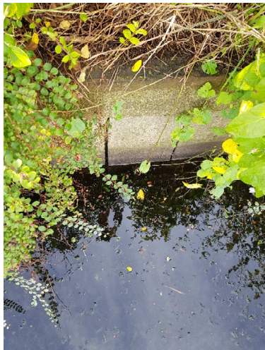
Foto 58: Situering beschoeiing Hunsingokanaal (betonnen damwand beschoeiing)
