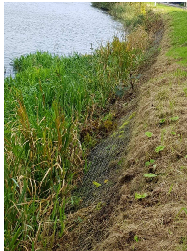
Foto 53: Situering uit te breiden aanlegplaatsen Hunsingokanaal (schanskorf beschoeiing)
