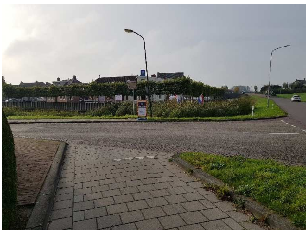
Foto 16: Situering toekomstig fietspad Spuistraat
