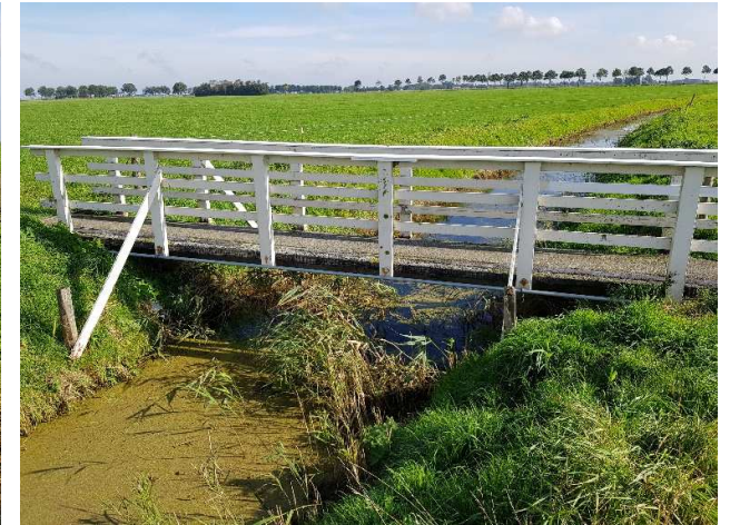
Foto 75: Situering bruggetje Panserpad
