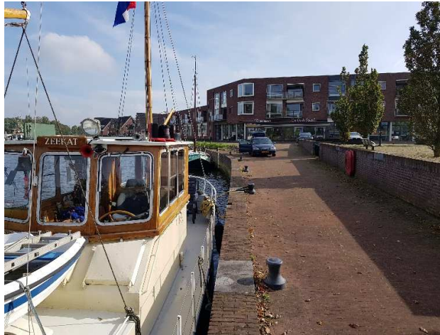
Foto 50: Situering uit te breiden aanlegplaatsen Hunsingokanaal
