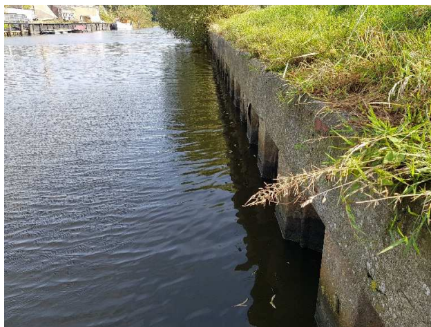
Foto 62: 6 Situering beschoeiing Hunsingokanaal (metalen damwand beschoeiing)
