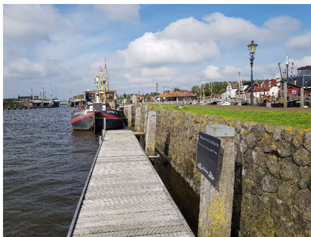
Foto 11: Situering aanmeervoorzieningen Reitdiep haven
