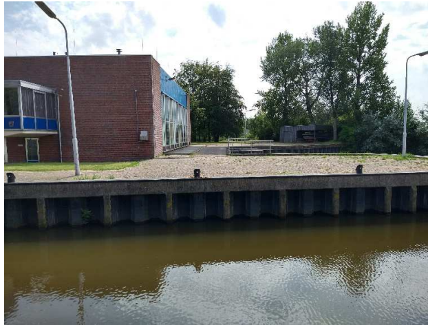
Foto 68: Situering H.D. Louwes gemaal
