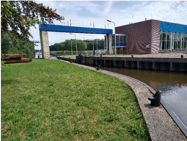
Foto 67: Situering H.D. Louwes gemaal
