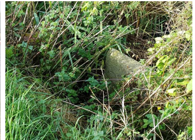
Foto 60: Situering beschoeiing Hunsingokanaal (overgang naar metalen damwand beschoeiing)
