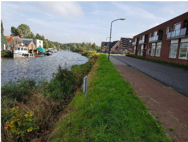
Foto 52: Situering uit te breiden aanlegplaatsen Hunsingokanaal
